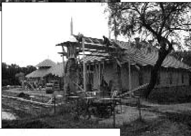
Építés közben: a főépület
