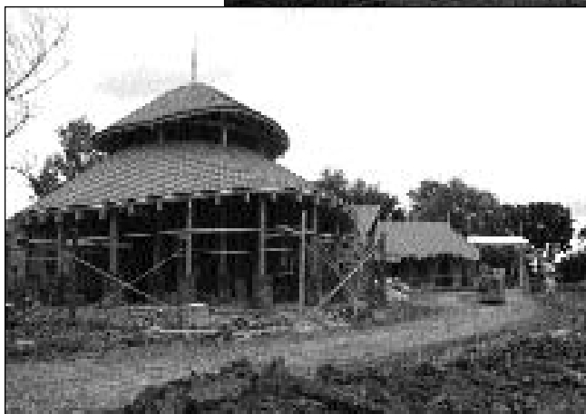
Építés közben: a bejárat
