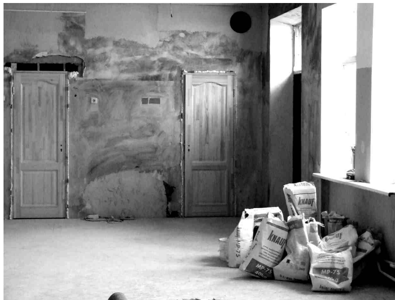
Remontdarbi skolas ēkas 2. korpusa 1. stāva gaitenī, kur tiek atjaunota grīdas, sienas, griesti un mācību kabinetu durvis.
