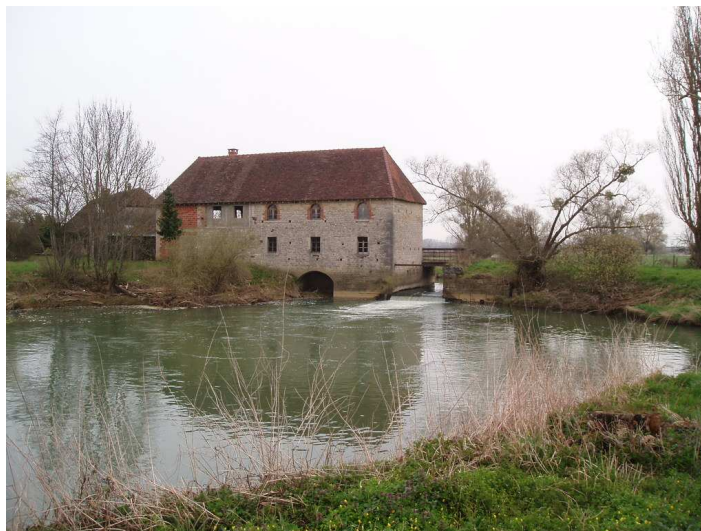
Photographie 11 : Moulin de Chante-Merle, habitation inondée en 1999
