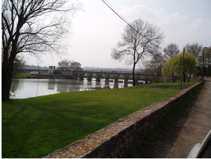
Photographie 24 : barrage sur la Seille en amont de la confluence avec la Saône
