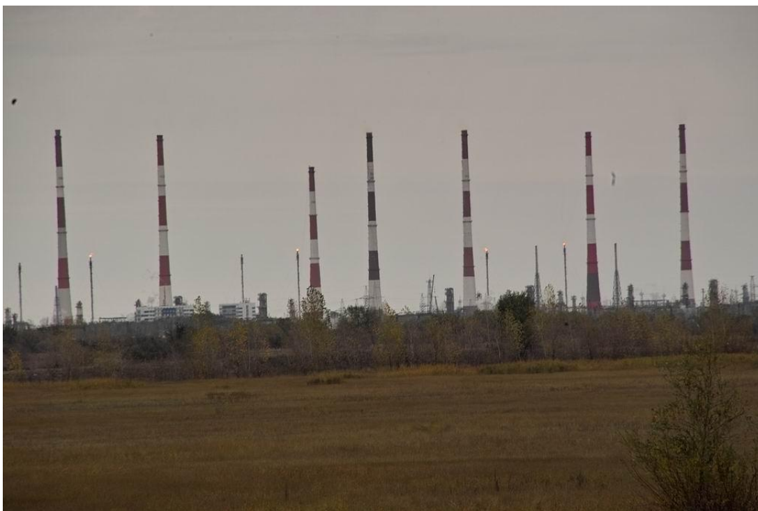
Рис.141. Астраханский газоперерабатывающий завод.
