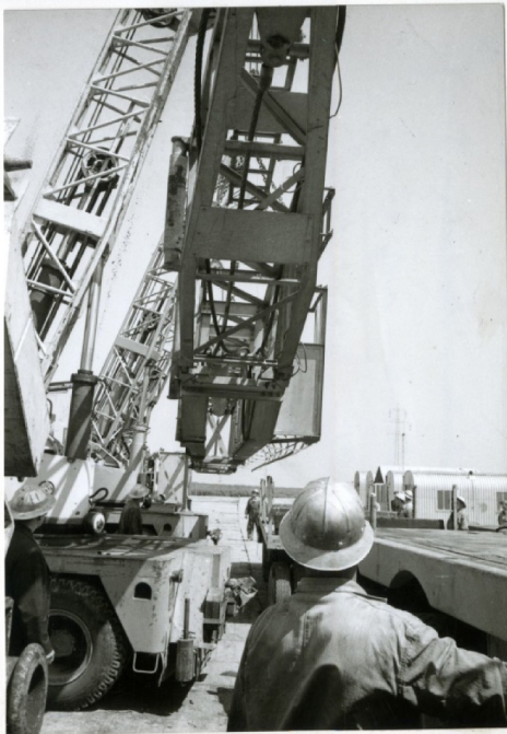
Der hochgehobene Mastschub I und II vor dem Absenken auf den bereit- gestellten Spezial-Anhänger
