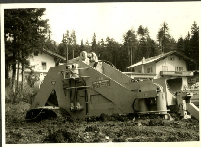
Fuhrpark Prottes beim Pipelinebau in Tirol [aus: Sammlung OMV-Fuhrpark Prottes\OMV-Fuhrpark Prottes_1963_66]
