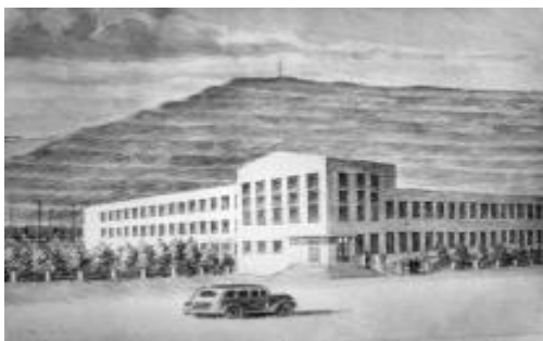
Здание МГМИ на Ежовке
