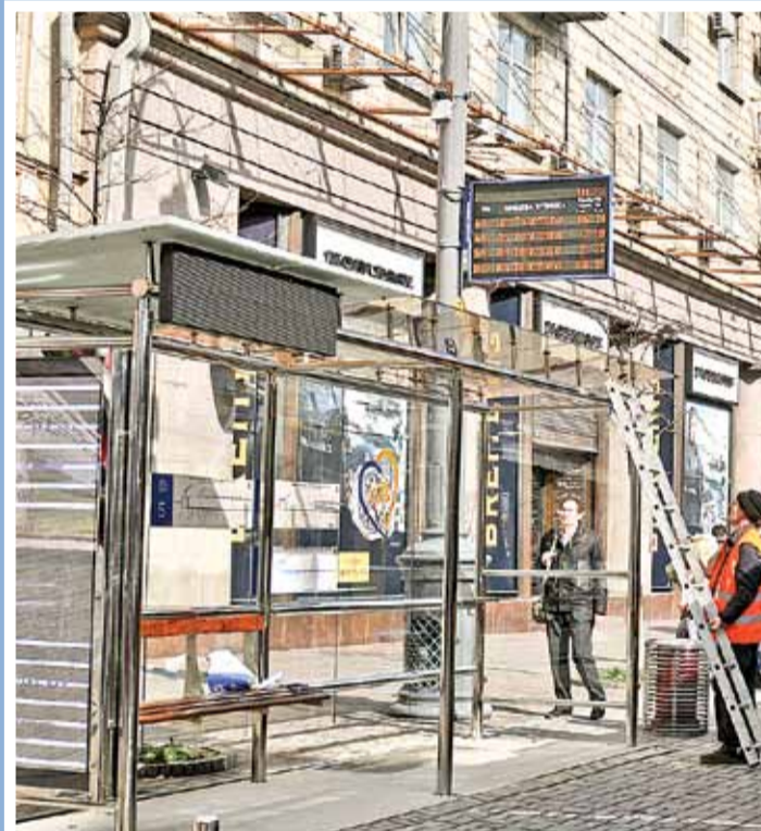
5 квітня. Розумна зупинка, що з'явилася на вул. Великій Васильківській, 4, одержує енергопостачання від сонячної батареї. Конструкція зупинки мобільна, не залежить від оперативного під'єднання до електромережі, дає змогу економити час на монтажі та погодженні документації. Тут є Wi-Fi, можна підзарядити телефон.
