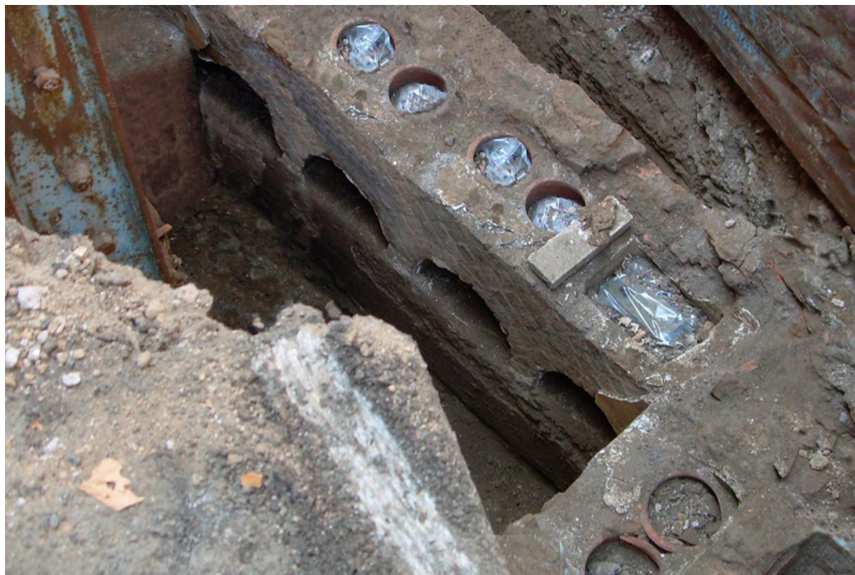
10. PARTICOLARE CON LE NICCHIE E LE OLLE NELLA MURATURA
