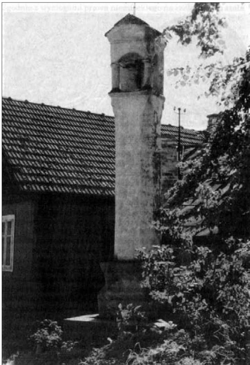
Fot. 20. Kaplica przy ul. Mickiewicza - XVII/XVIII w.
