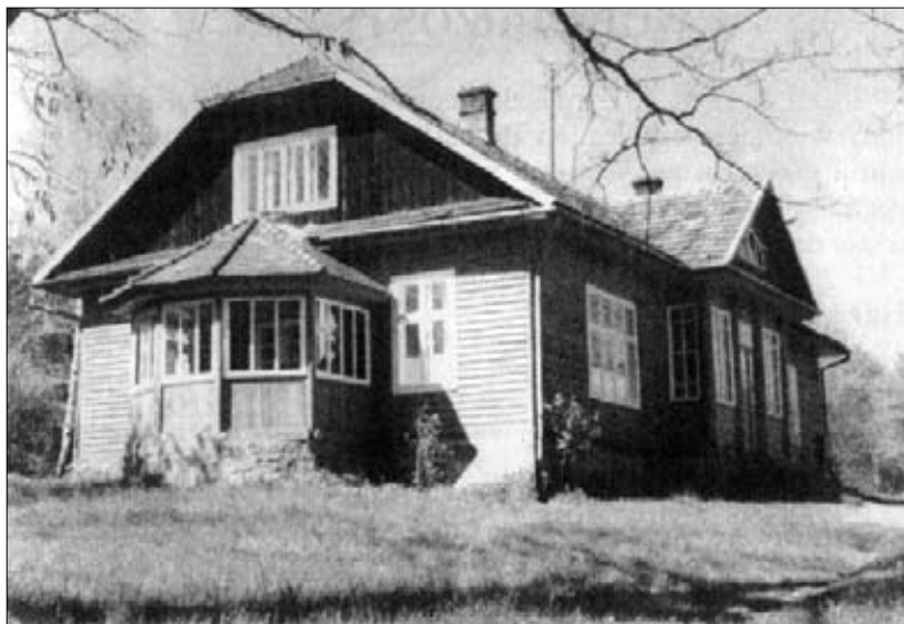
Fot. 94. Dwór w Smarżowej
