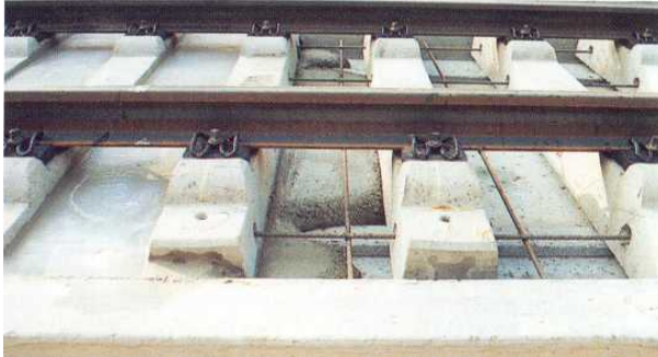
Figuur 52: Rheda constructie (details)
