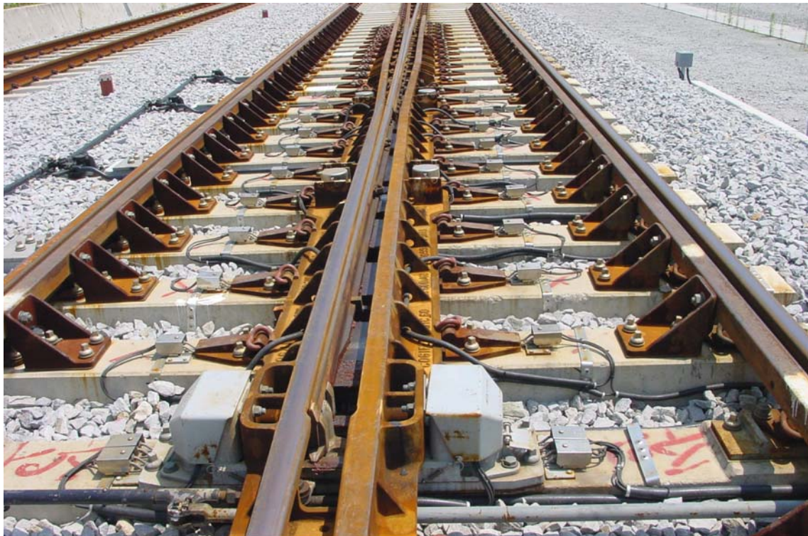
Figuur 10: Beweebaar puntstuk in hogesnelheidswissel
