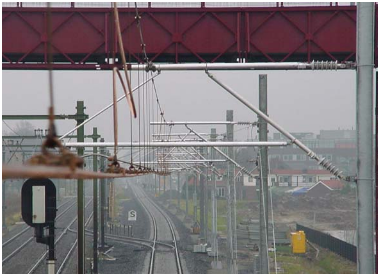
Figuur 134: B4 bovenleidingsysteem
