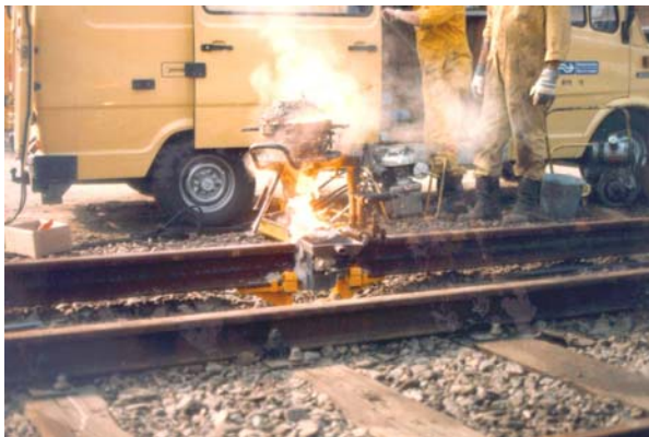
Figuur 35: Thermietlasproces in actie
