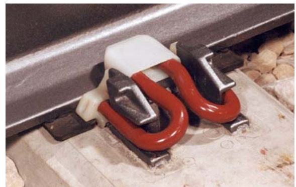
Figuur 43: Pandrol bevestiging
