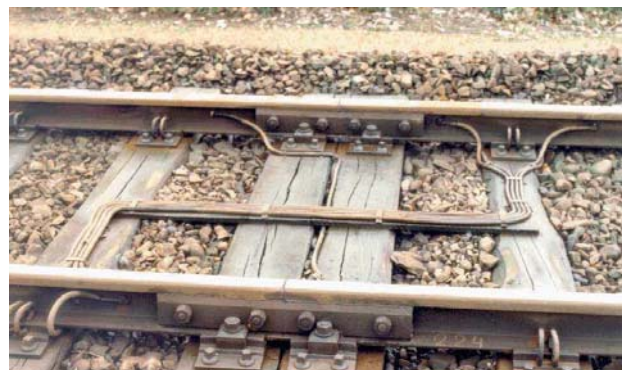
Figuur 31: Gelijmde isolatielas in de spoorbaan
