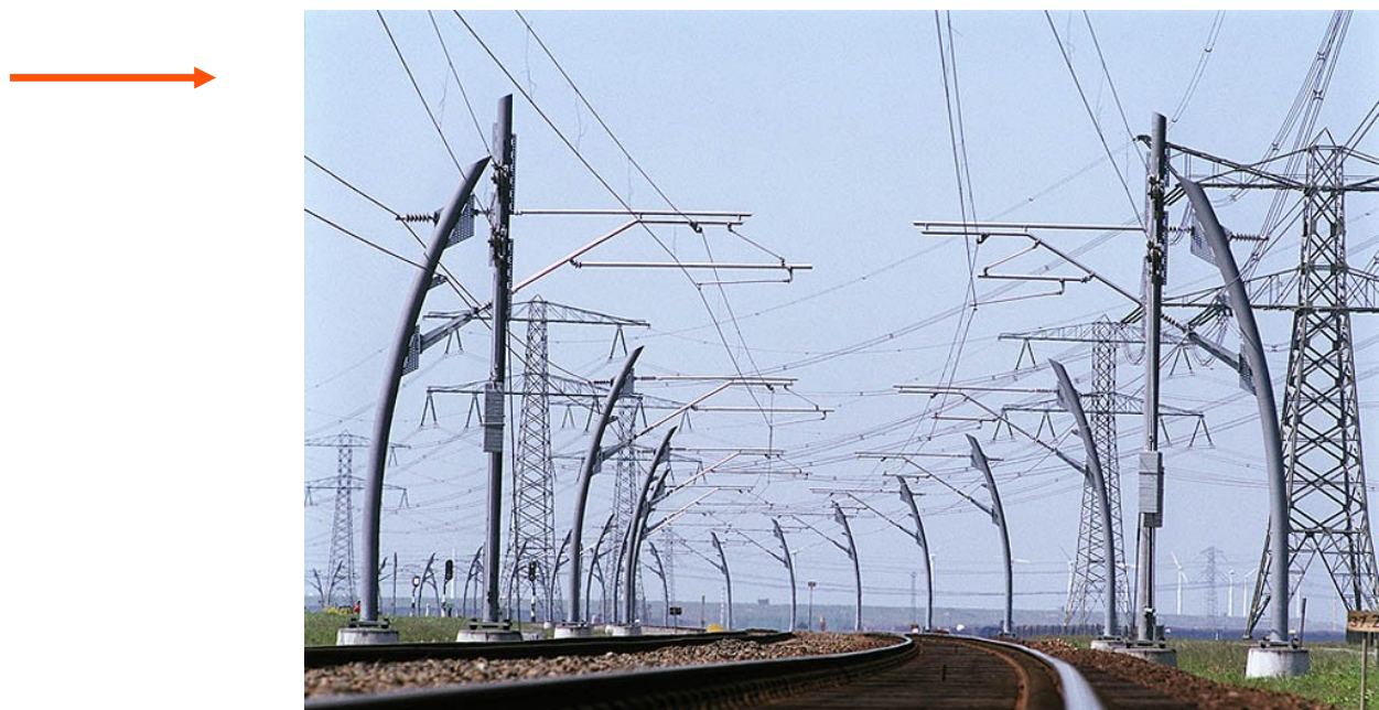
Figuur 109 Overzicht geleiders bij een 25 kVAC AT-systeem.
