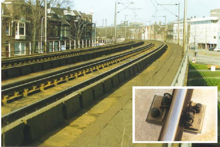
Figuur 50: Directe bevestiging (spoorviaduct Delft)
