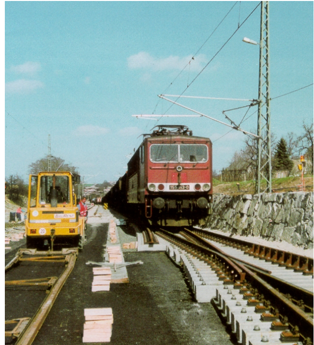
Figuur 84: onderbroken dwarsliggers in wissel t.b.v. gefaseerde aanleg
