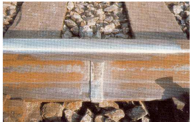
Figuur 36: Thermietlas: eindproduct
