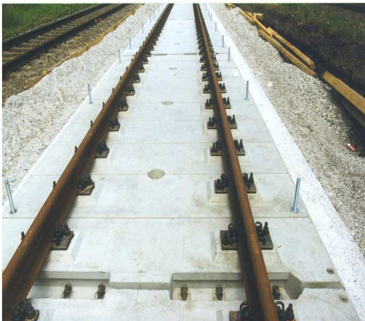
Figuur 51: Platenspoor van voorgespannen beton (Duitsland)
