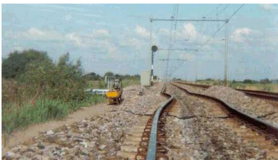
Figuur 17: Spoorspatting in de spoorbaan
