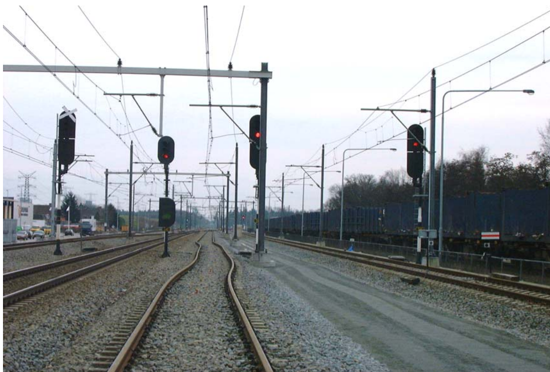
Figuur 82: Een ongewenst dwarsprofiel (let op de zeer onlogische plaats van seinen achter bovenleidingmasten).
