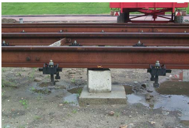
Figuur 67: Gesloten trambaanconstructie in uitvoering. Groefrail Ri60 op kunststof platen.
