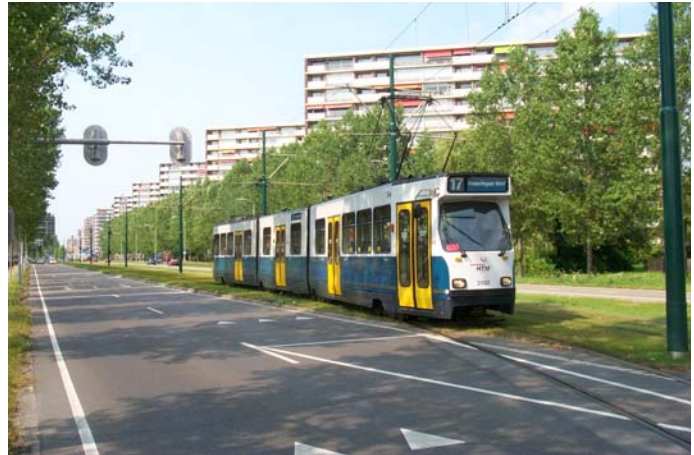
Figuur 65: Open trambaanconstructie. Tramlijn 17 van Den Haag naar Wateringse Veld in grasbaan.
