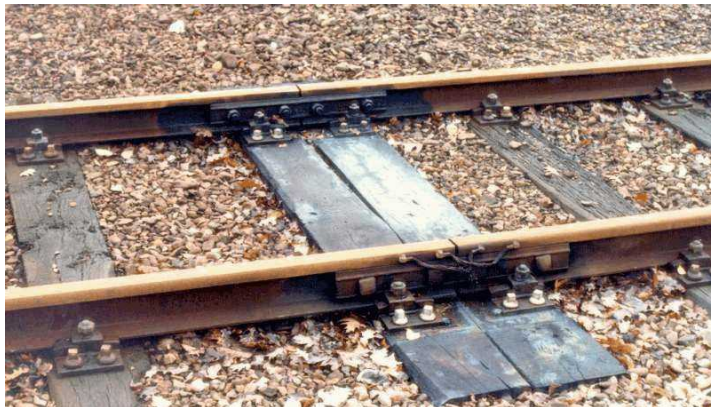
Figuur 25: Plaatlas ('K-Oberbau') in de spoorbaan
