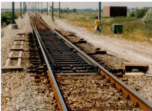
Figuur 7: Gewoon rechts wissel
