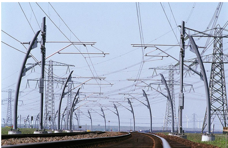
Figuur 133: B5 bovenleidingsysteem
