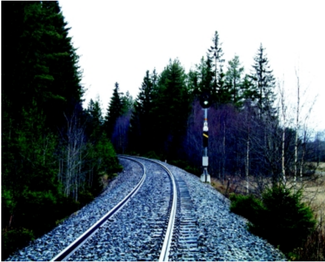
Figur 4.5 Grønt forsignal innkjør til Rudstad stasjon sett sydfra Kilde: Foto fra Jernbaneverket
