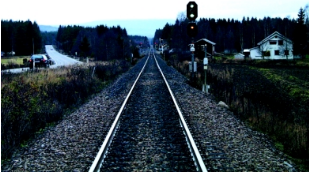
Figur 4.7 Grønt innkjørsignal til og gult forsignal utkjør fra Rudstad stasjon sett sydfra Kilde: Foto fra Jernbaneverket
