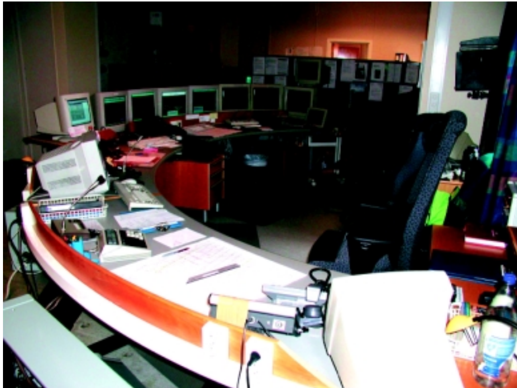
Figur 6.1 Hamar togledersentral. Arbeidsplassen for overvåking av Rørosbanen lengst bak Kilde: Foto fra Jernbaneverket
