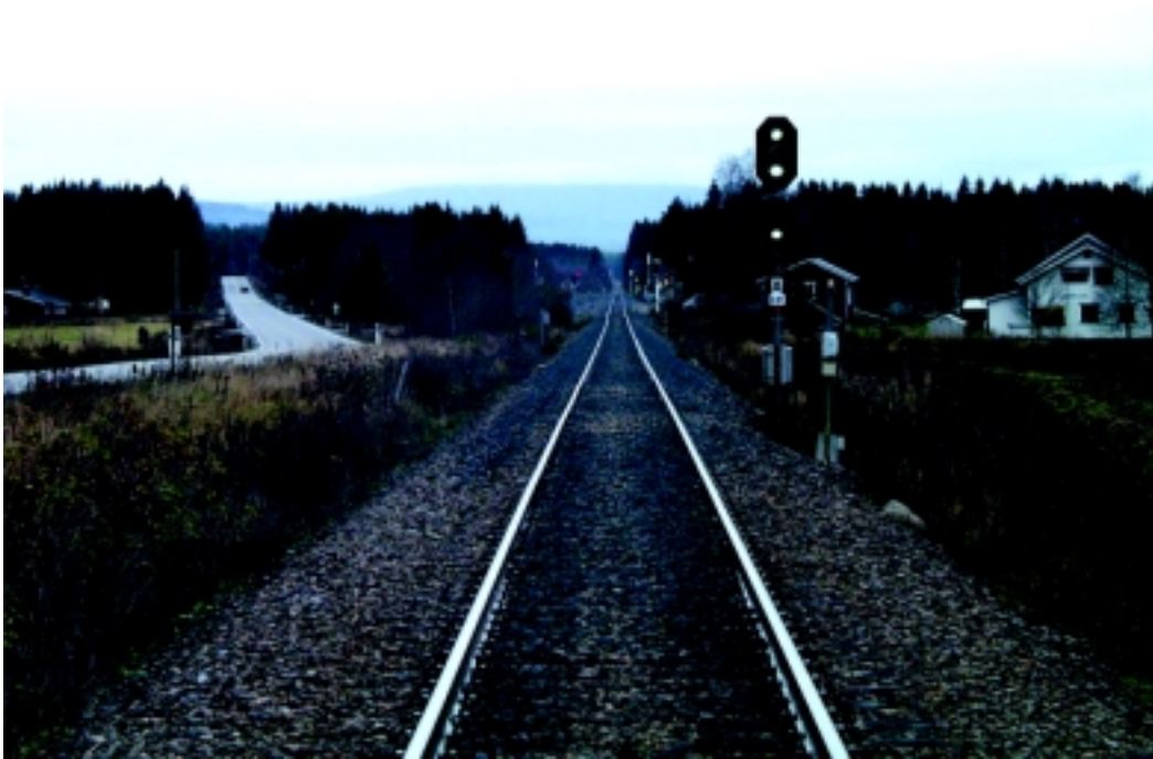
Figur 4.6 Grønt innkjørsignal til og grønt forsignal utkjør fra Rudstad stasjon sett sydfra Kilde: Foto fra Jernbaneverket
