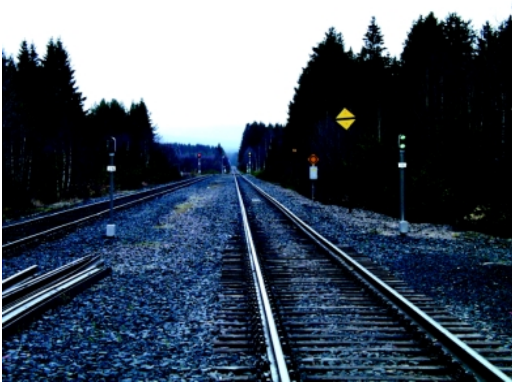
Figur 4.8 Togsporsignal med grønt lys på Rudstad stasjon sett sydfra Kilde: Foto fra Jernbaneverket
