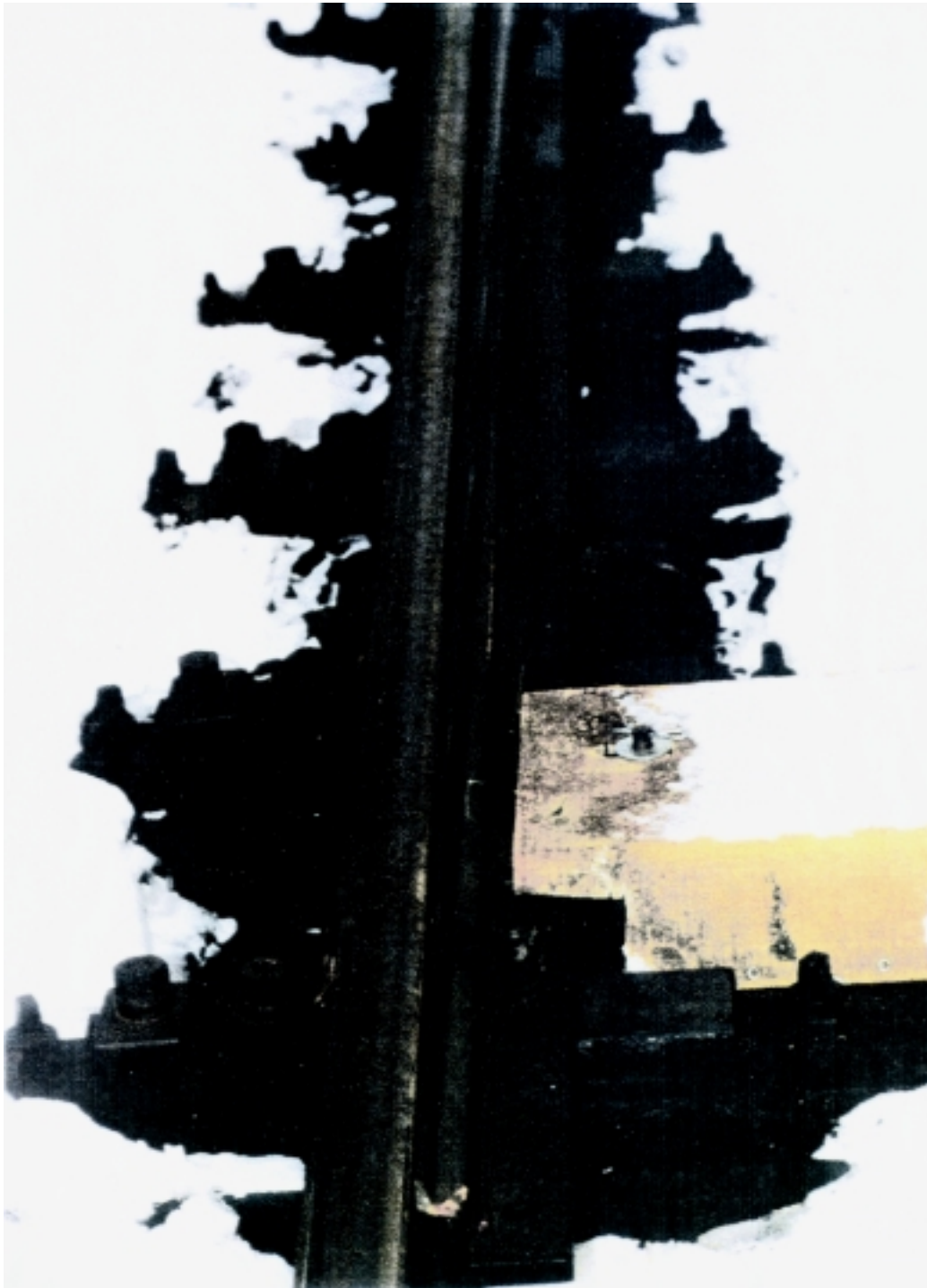
Figur 4.32 Høyre sporvekseltunge i tilleggende stilling (- stilling)
