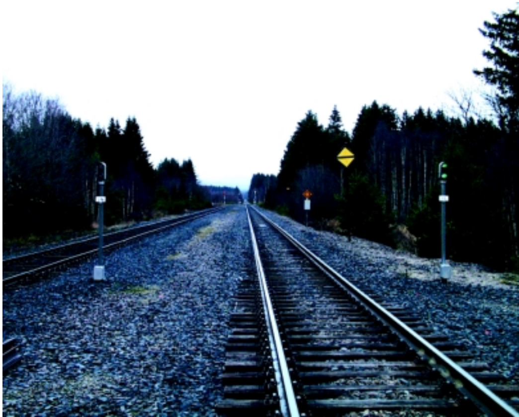
Figur 4.9 Togsporsignal med slukket lys på Rudstad stasjon sett sydfra Kilde: Foto fra Jernbaneverket
