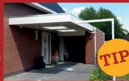
EIGEN LIJN CARPORTS
