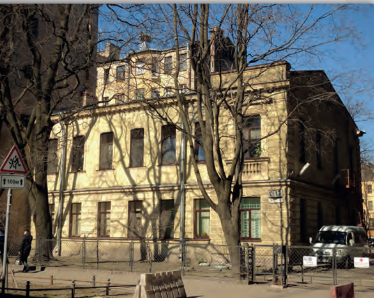
Вид здания в настоящее время
