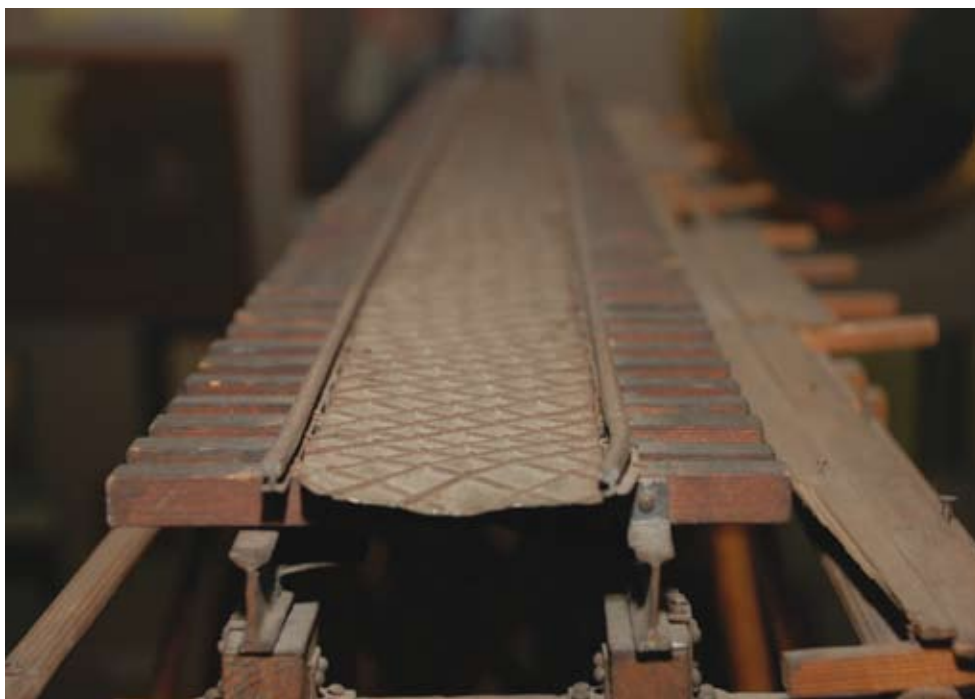
Rifliuota geležimi išklotas geležinkelio tarpubėgis
