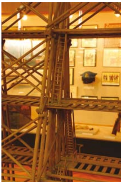
Medinės kopėčios, kuriomis gaisrininkai galėjo pasiekti kiekvieną tilto dalį
