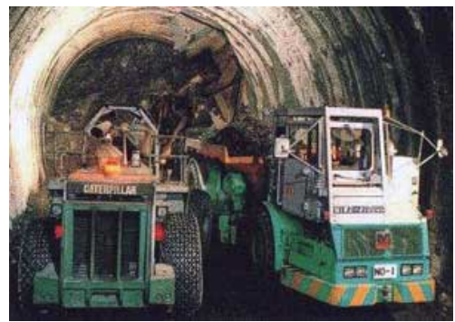
山岳トンネルの工事状況
