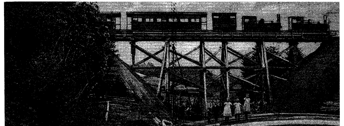
Egtvedbanens tog passerer interimskonstruktionen, som skulle støtte banen under tunnelbyggeriet. Billedet er taget fra Bramdrupdam kros have.
