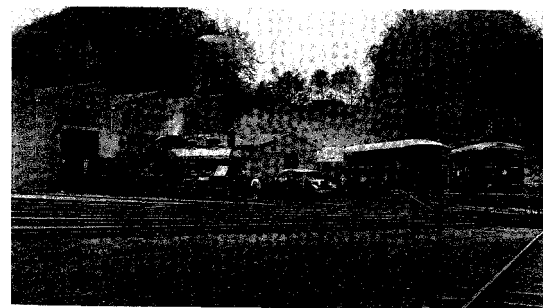
Troldhedebanens remise ved Ndr. Ringvej.
