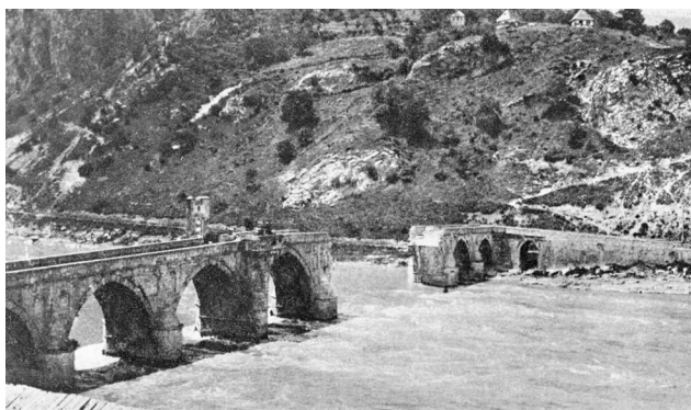
Вишеградски мост срушен
