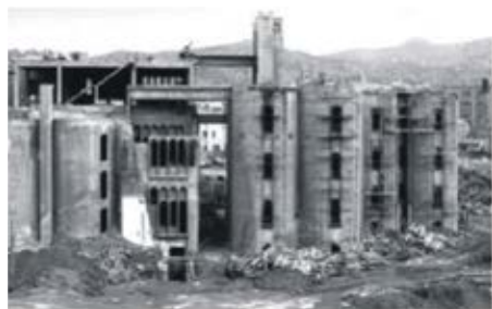
Цементний завод, м. Барселона, Іспанія
