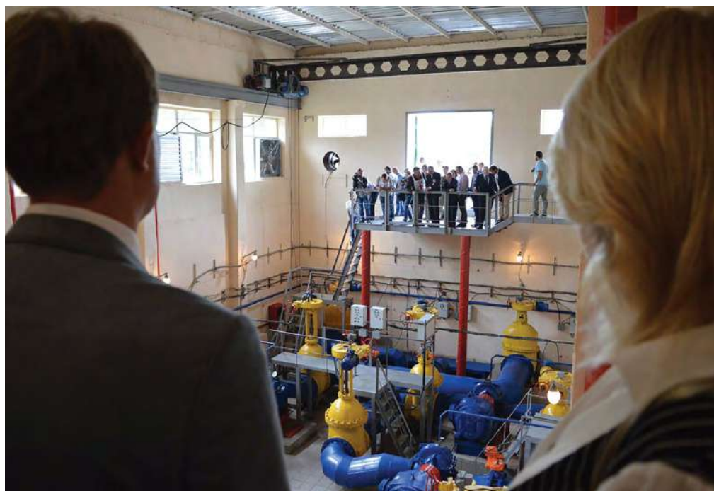
Відкриття Карлівської насосної станції після реконструкції за підтримки Міжнародного комітету Червоного Хреста
