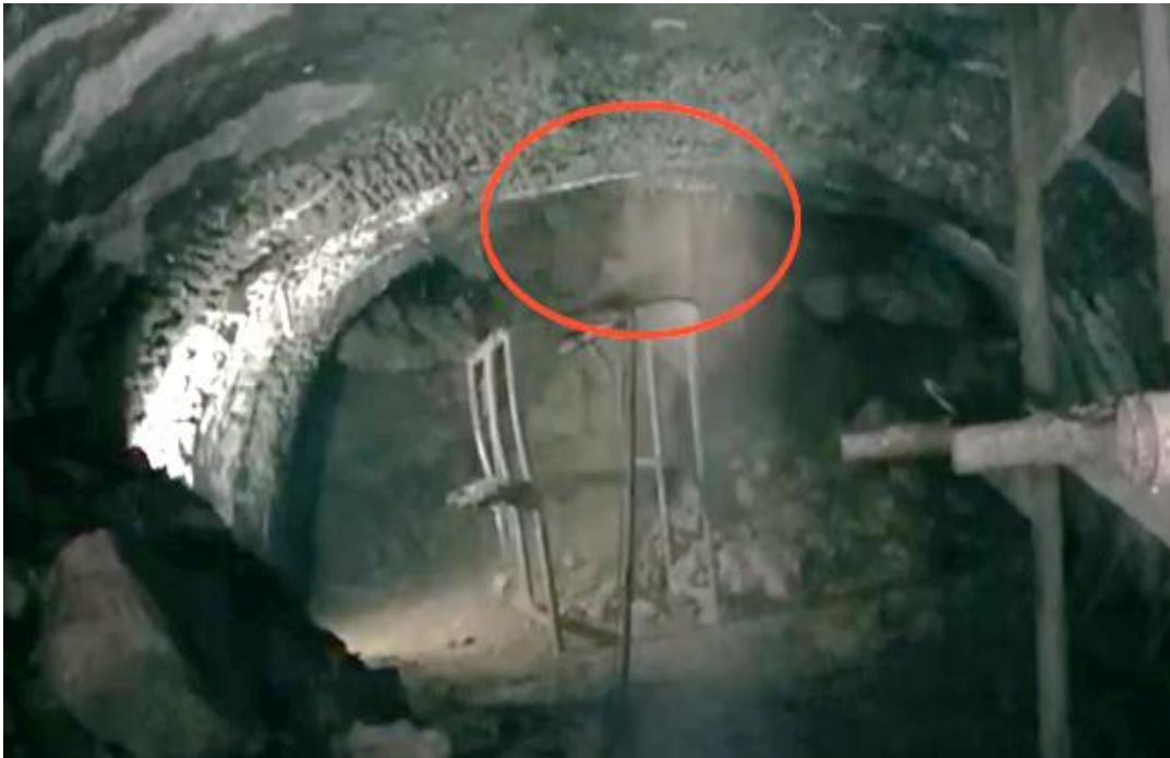
图示：掌子面拱顶突泥涌砂视频截图
