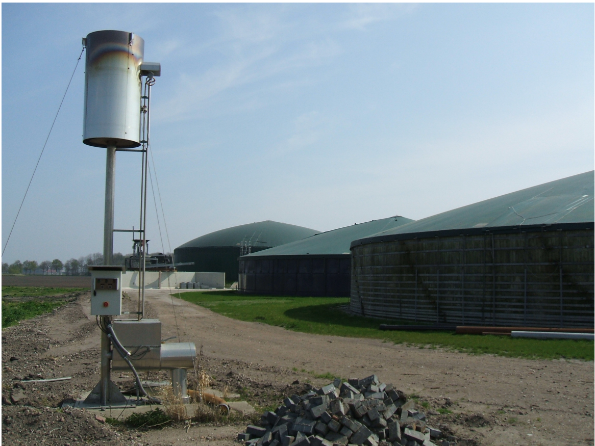
Figuur 3 Automatische fakkelininstallatie die een overschot aan biogas verbrandt welke wordt geactiveerd als de overdruk in de vergister hoger is dan 3,2 mbar (Jansen Wijhe Energy bv te Kiel-Windeweer, 17 april 2009).
