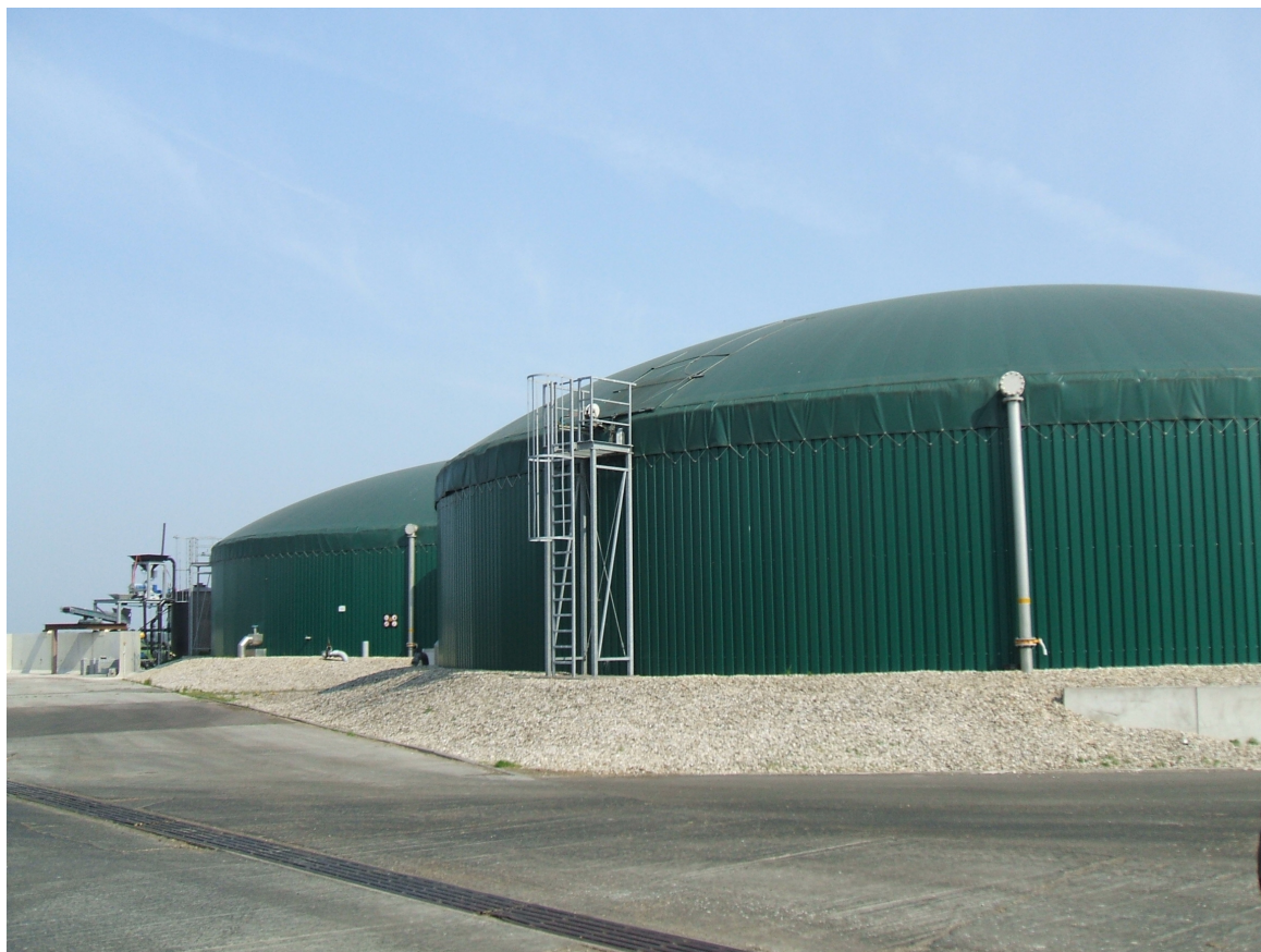
Figuur 1 Een voorbeeld van een typische vergister voor de productie van biogas (Jansen Wijhe Energy bv te Kiel-Windeweer, 17 april 2009).
