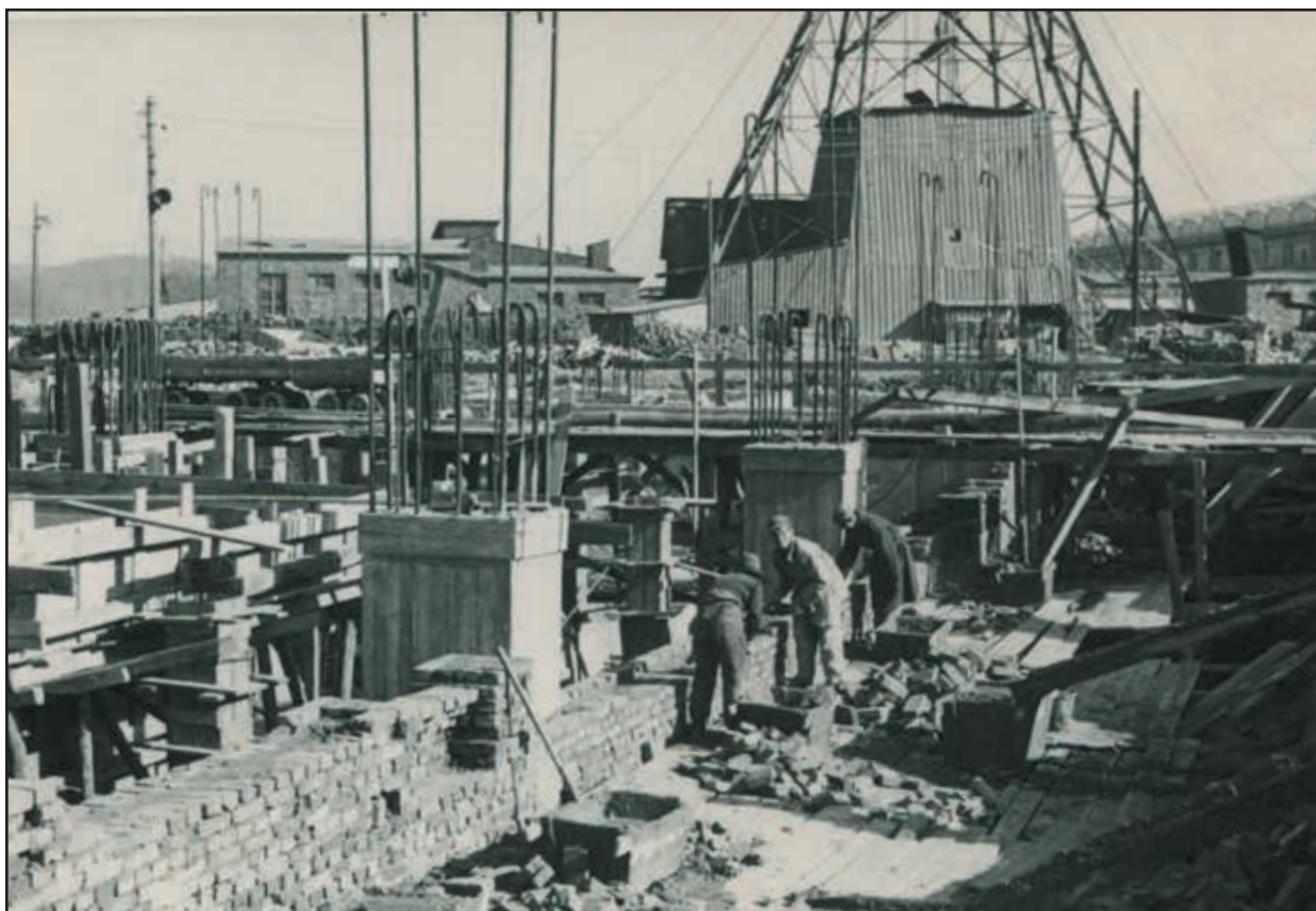
Budowa Zakładów Górniczych „Konrad”, 16.10.1951 r.
