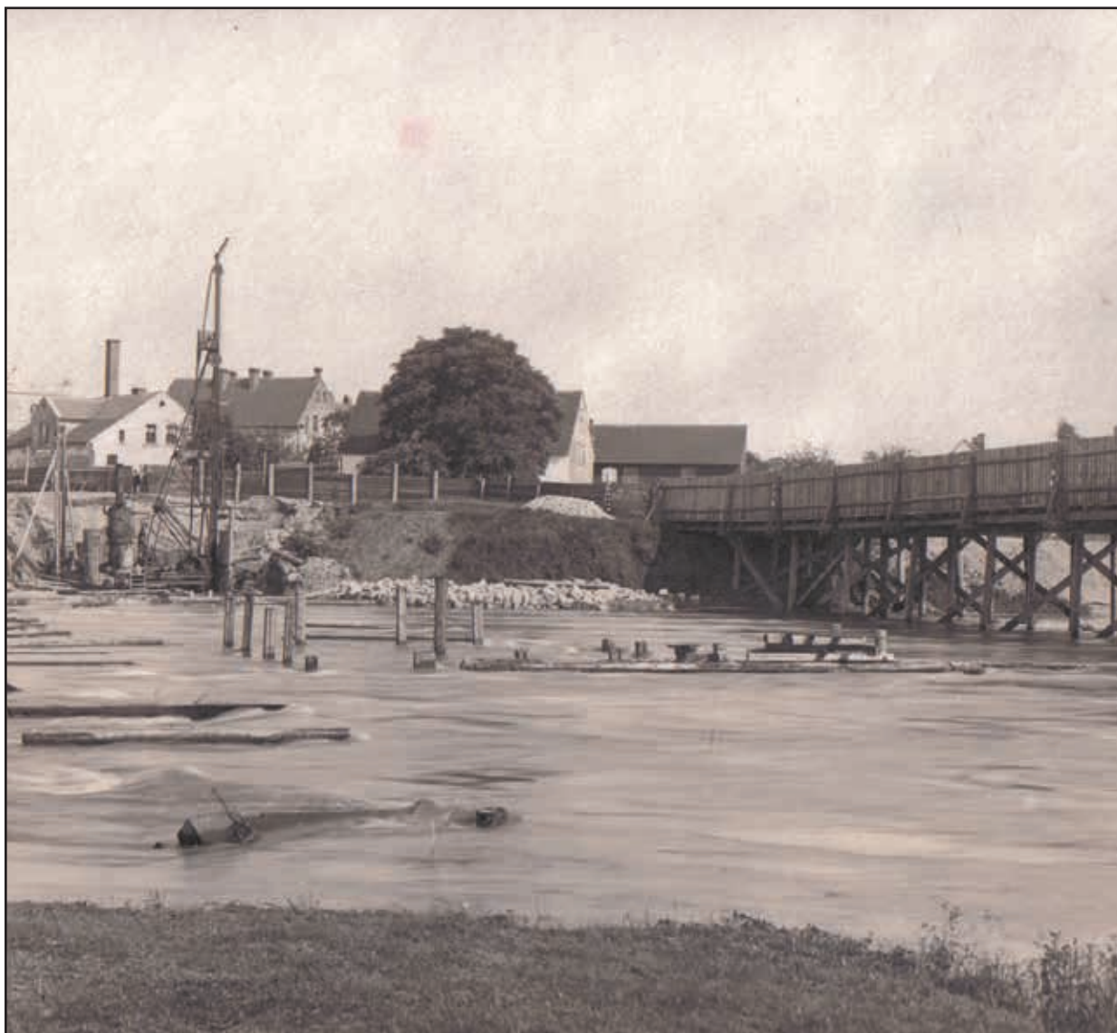
Prace budowlane przy moście na Bobrze, 1919 r.
