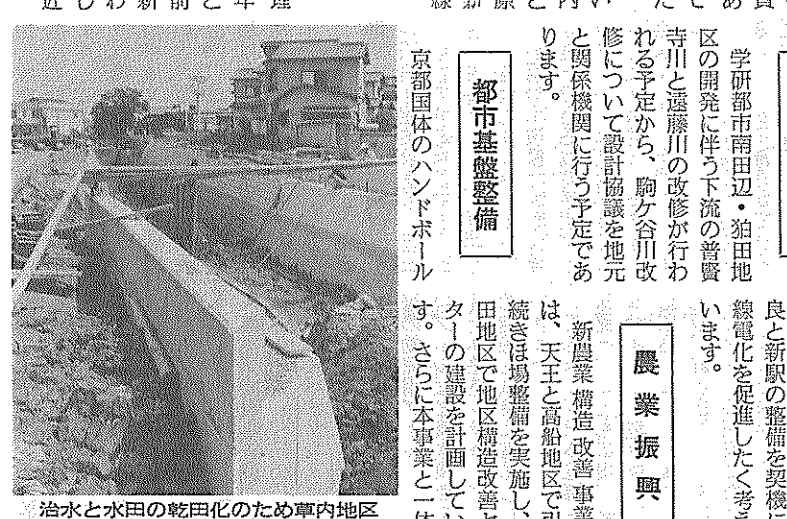
治水と水田の乾田化のため管内地区で進む府管排水対策特別事業
