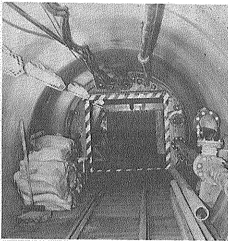
⑦一般家庭への共用開始に向け、公共下水道工事が着々と進んでいます(松井)
