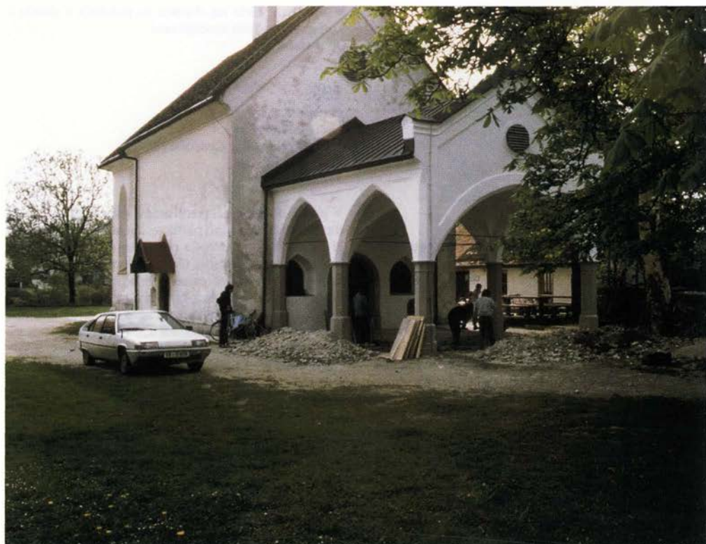
Kranj, p. c. sv. Roka, situacija izkopavanja (foto Milan Sagadin).
