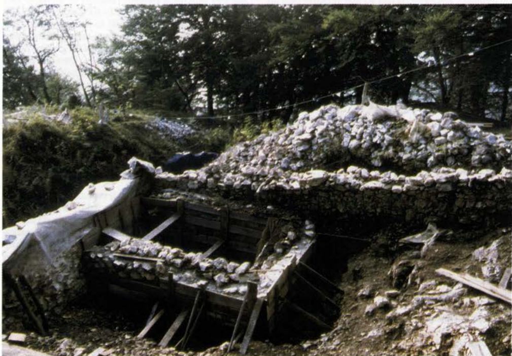
Ajdna nad Potoki, sanacija vodne cisterne v objektu (foto Milan Sagadin).
