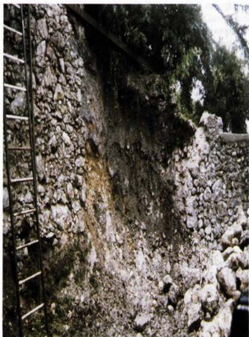
Mali grad, gradnja novega zidu pod Veronikinim portalom (foto Milan Sagadin).
