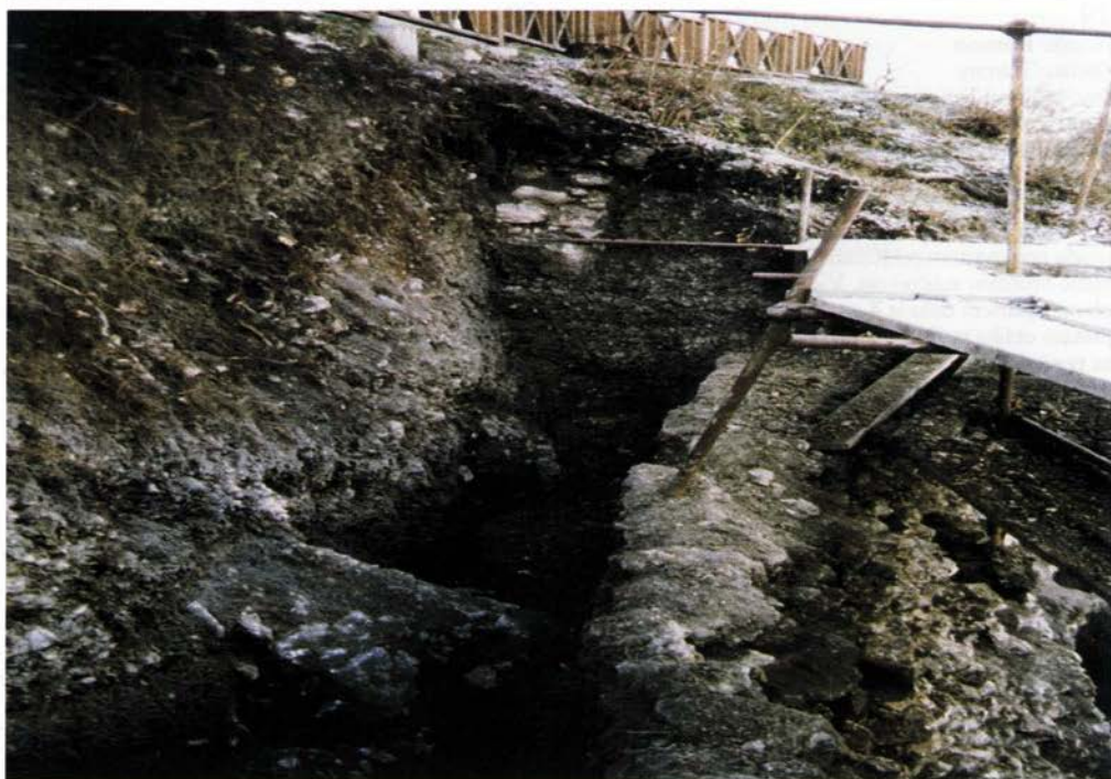
Mali grad, iskanje temeljev za novi zid pod malograjsko kapelo (foto Milan Sagadin).
