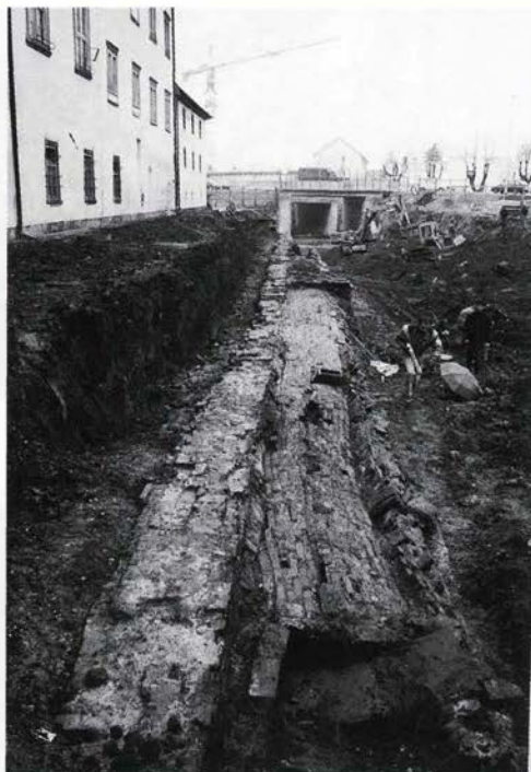
Ptuj, odkrita linija srednje – novoveškega obzidja in nanj prislonežen opečnat obokan kanalizacijski kanal (foto Marija Lubšina - Tušek).
