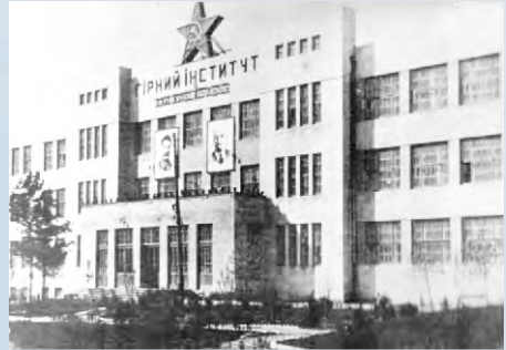
Корпус «гірного інституту» (40-і роки ХХ ст.)
