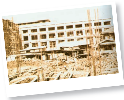
◀ การก่อสร้างอาคารศาลาเทศบาลกรุงเทพมหานคร ซึ่งมีการเปลี่ยนแปลงจากแบบที่กำหนดไว้เดิม
