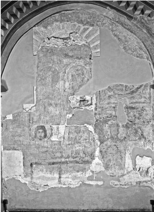
Рис. 2. Северная стена вимы придела свв. Антония и Феодосия. Вид после реставрационных работ 1982 г.
