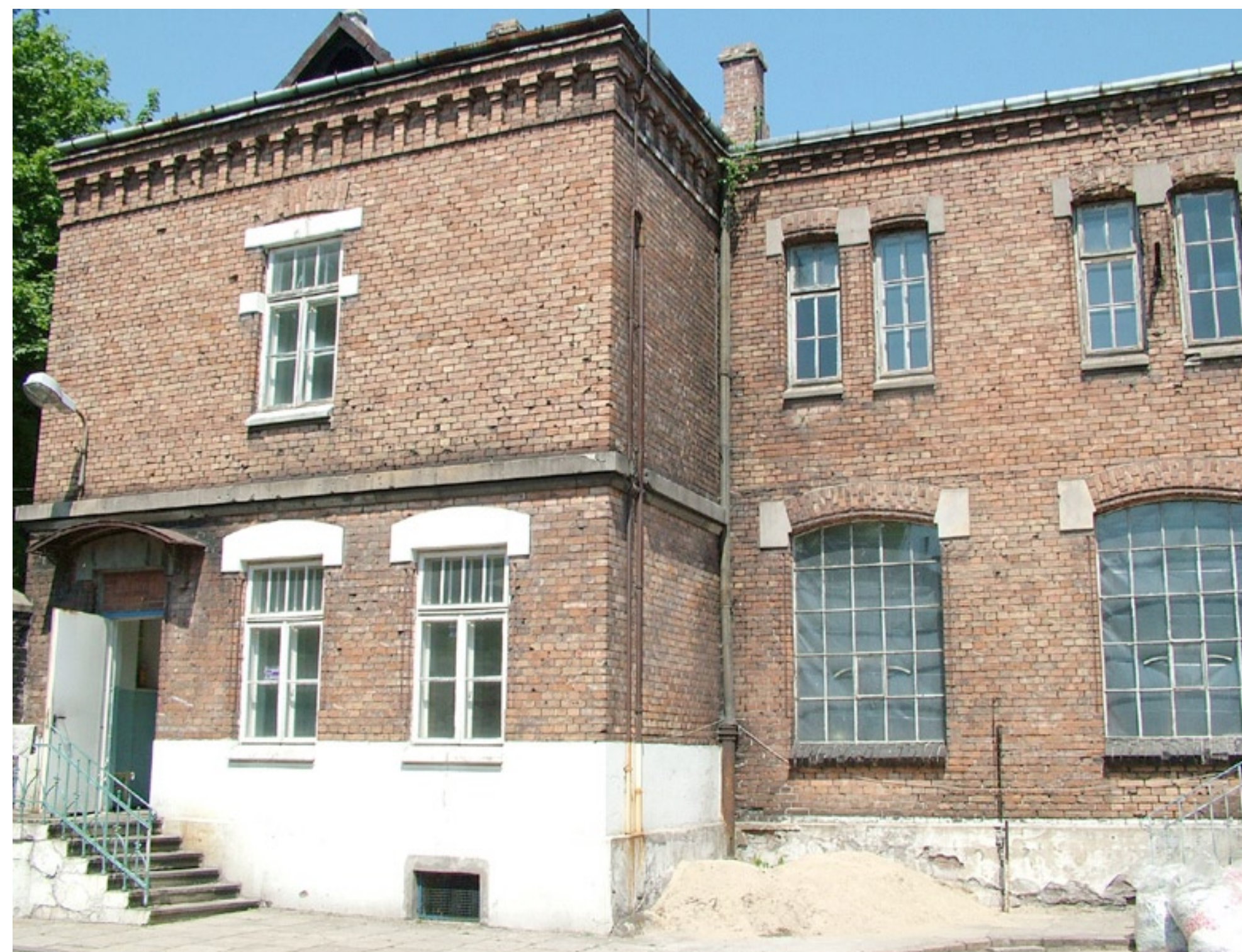
Wnętrza budynku ASP przy ul. Spokojnej. Interiors of the building in Spokojna Street.
