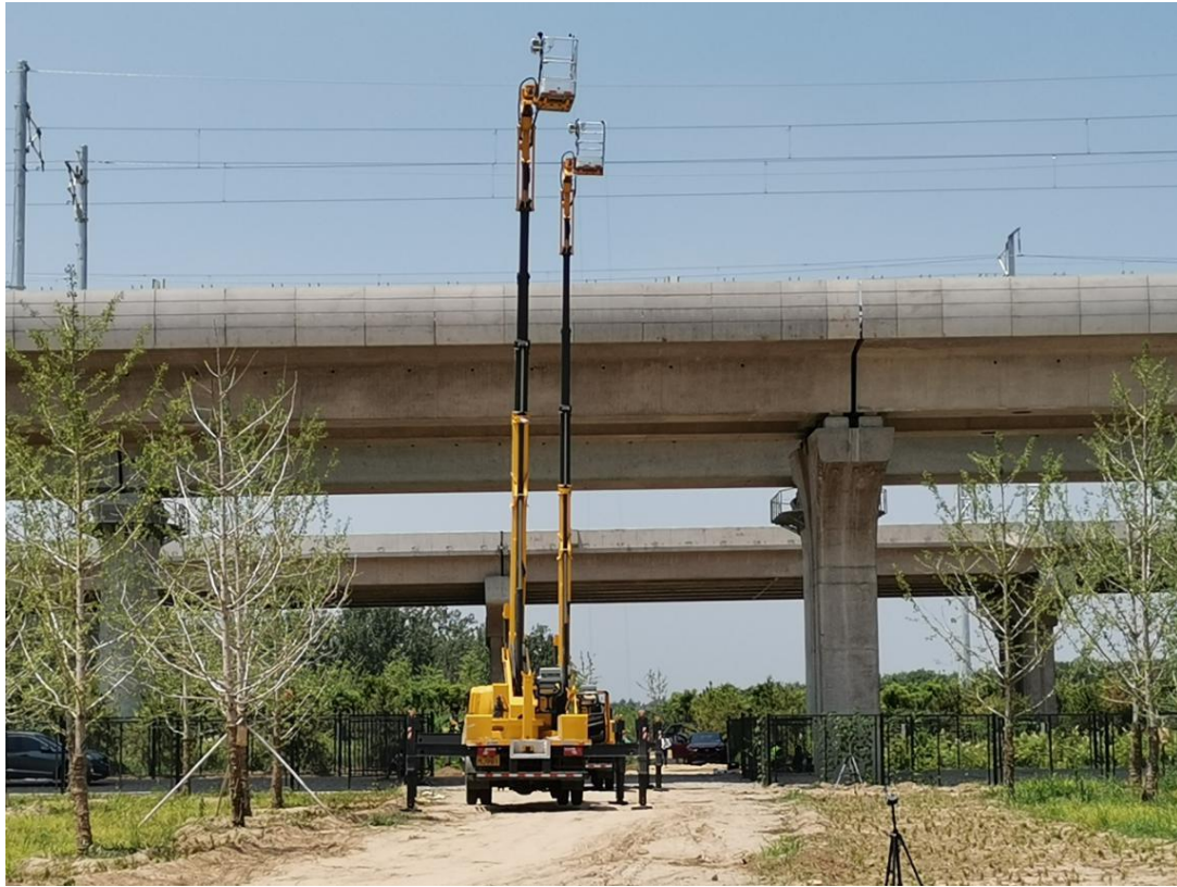
图 2.3-3 桥梁断面类比测试现场
