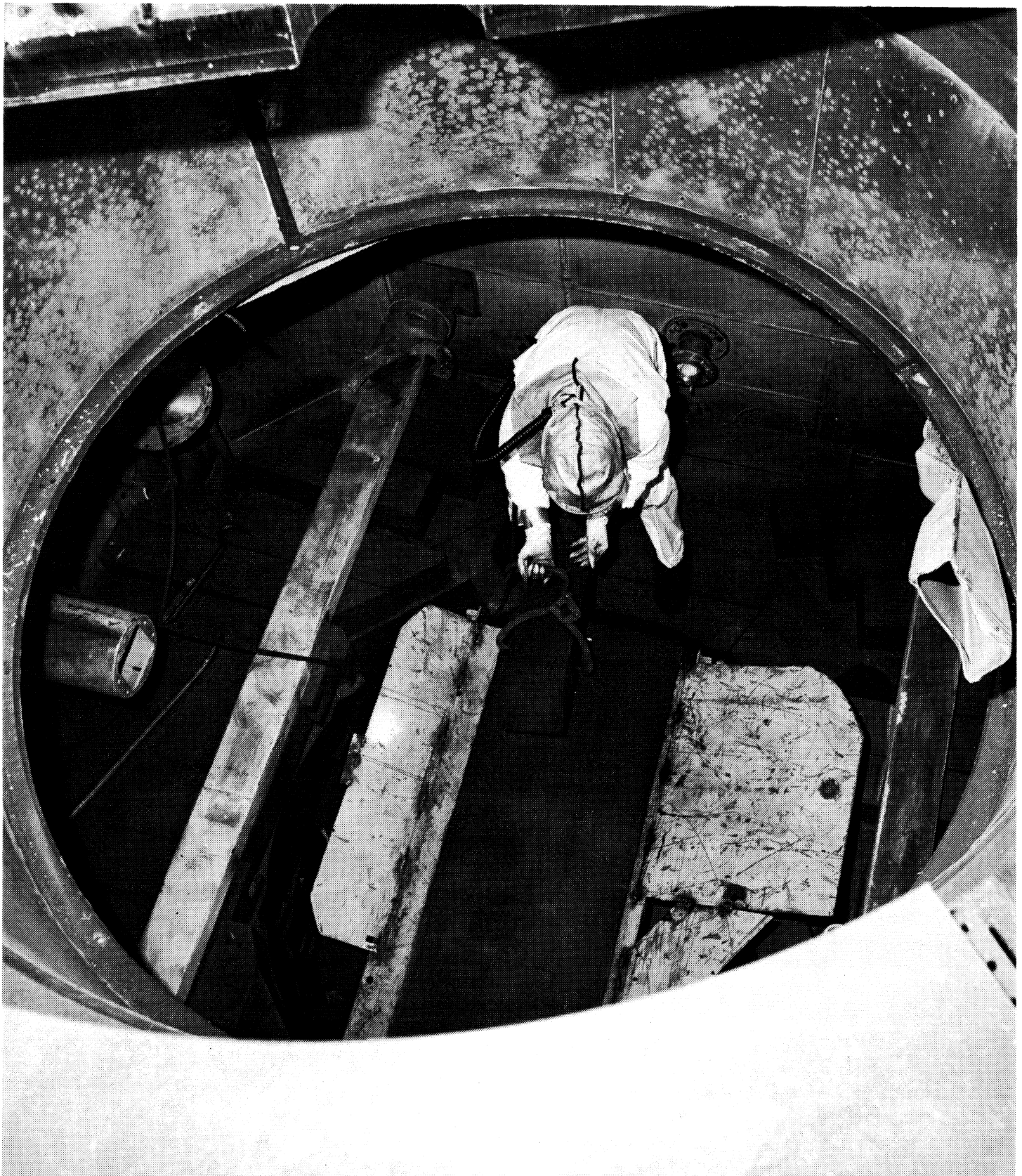
Fig 3.3. Arbete med rivning av grafitreflektorn som var belägen runt reaktortanken till R1-reaktorn i Stockholm. Under arbetet måste personalen på grund av dammriskerna vara iförd andningsskydd, vilket framgår av figuren.
