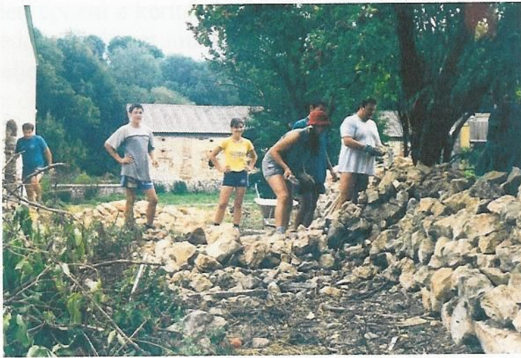
A kőfal építése, tereprendezés (Sz. Gy.)
