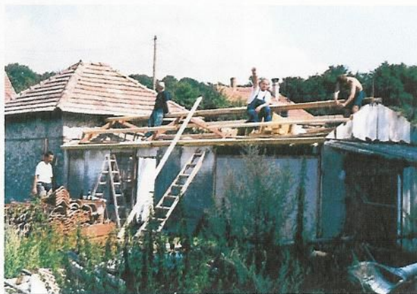
A hangár tető felújítása (M. J.)
