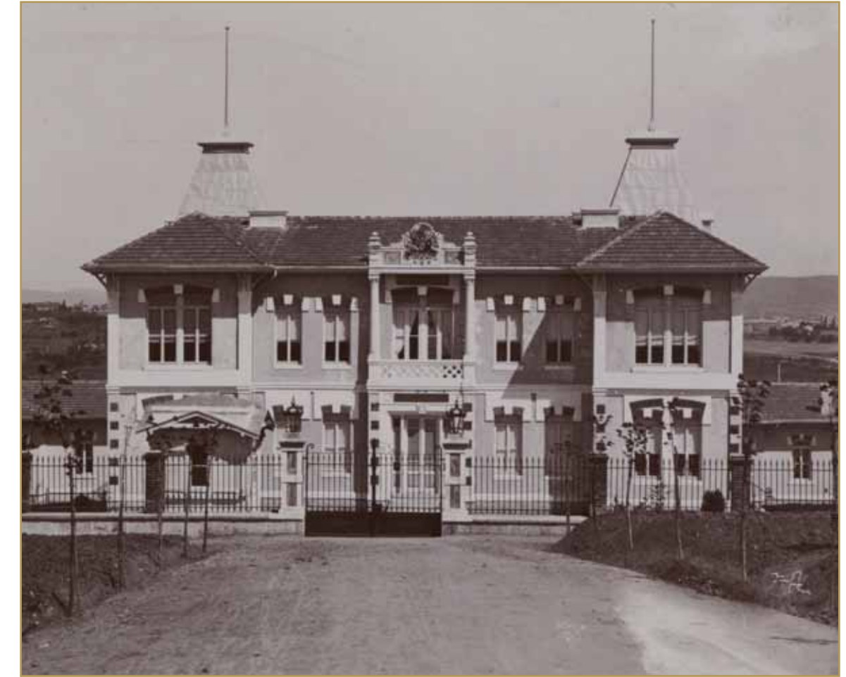
Merkez binanın cepheden görünüşü (Album, 90870/06)
