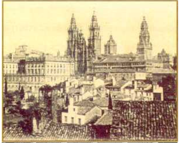
Fotografía de conjunto de la Catedral de Santiago y su entorno.
