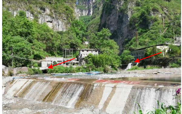
顺水河电站、金河电站发电尾水（作为金河电站）
