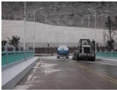
施工区道路洒水降尘
