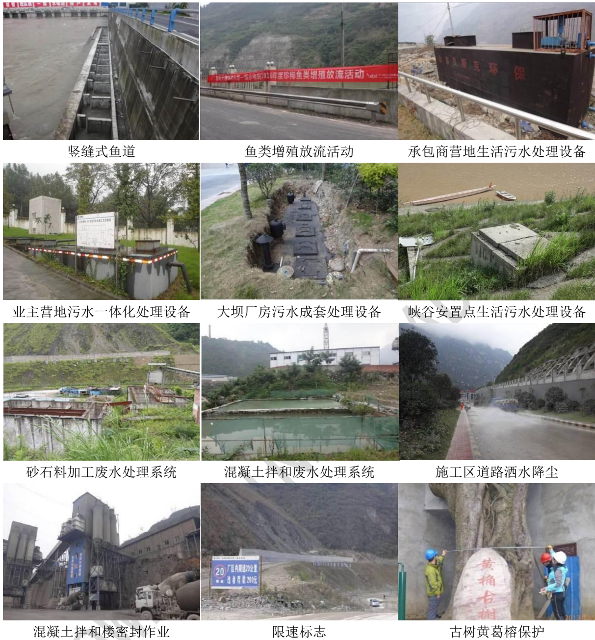
图 2.1-2 枕头坝一级水电站主要环境保护措施实施面貌
