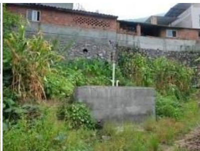
中坪村移民安置点化粪池
