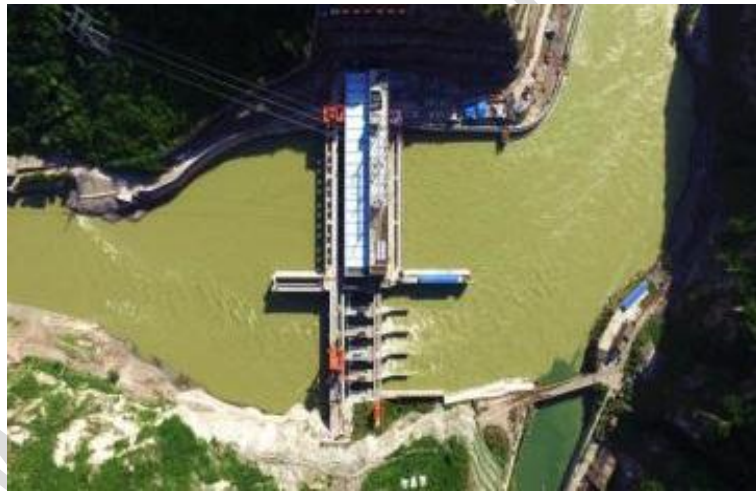
图 2.1-3 沙坪二级水电站现状面貌
