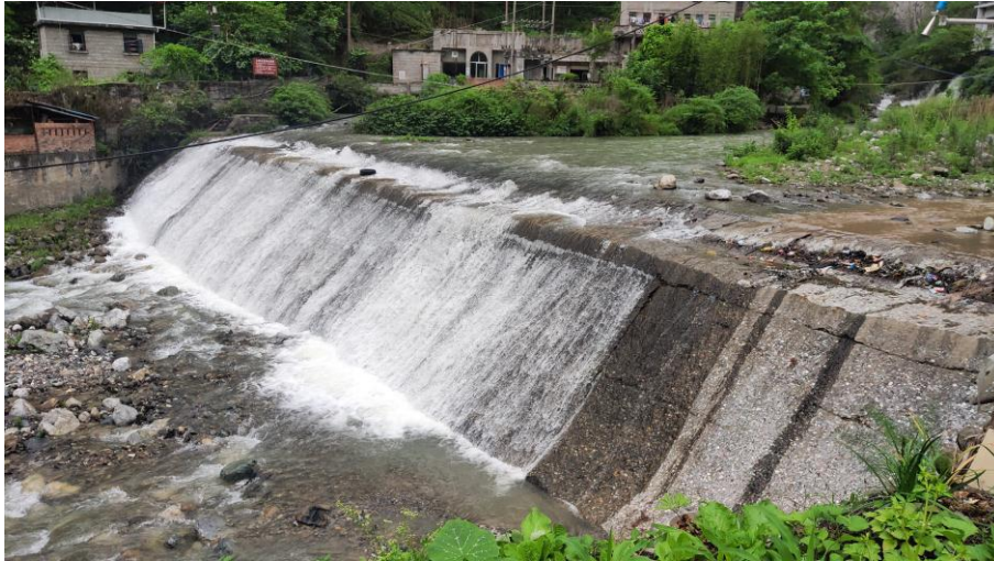
图 8.3-4 金口河河口电站拦水坝现状
