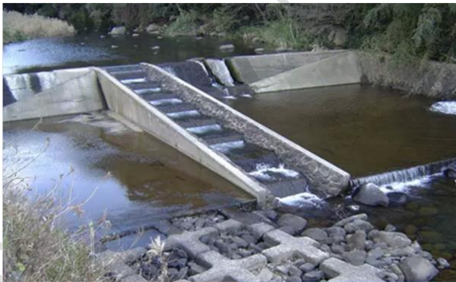
图 8.3-5 金口河河口电站拦水坝鱼坡效果
