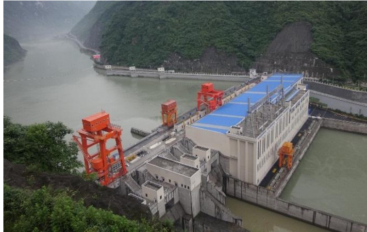
图 2.1-1 枕头坝一级水电站现状面貌
