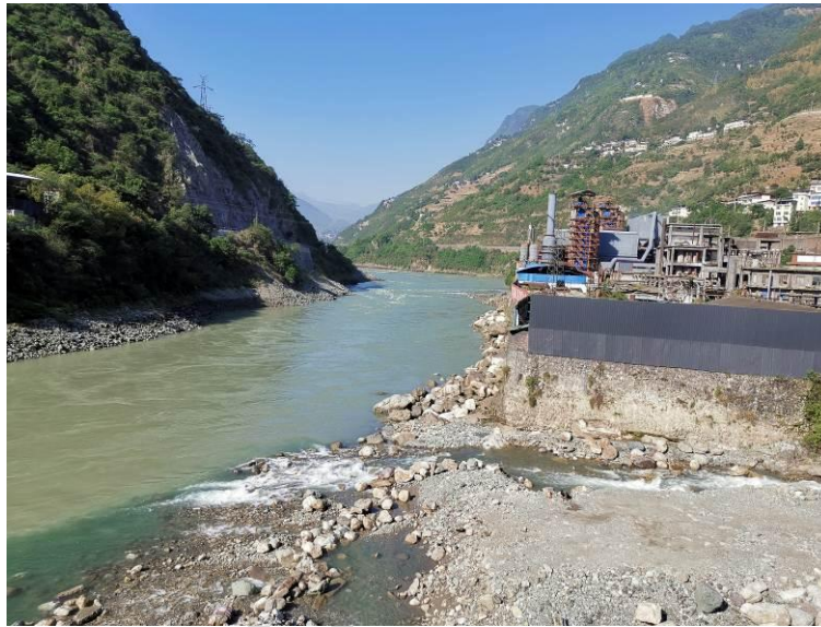
图 8.3-1 沙坪一级坝址至沙坪二级水电站库尾流水天然河段现状
