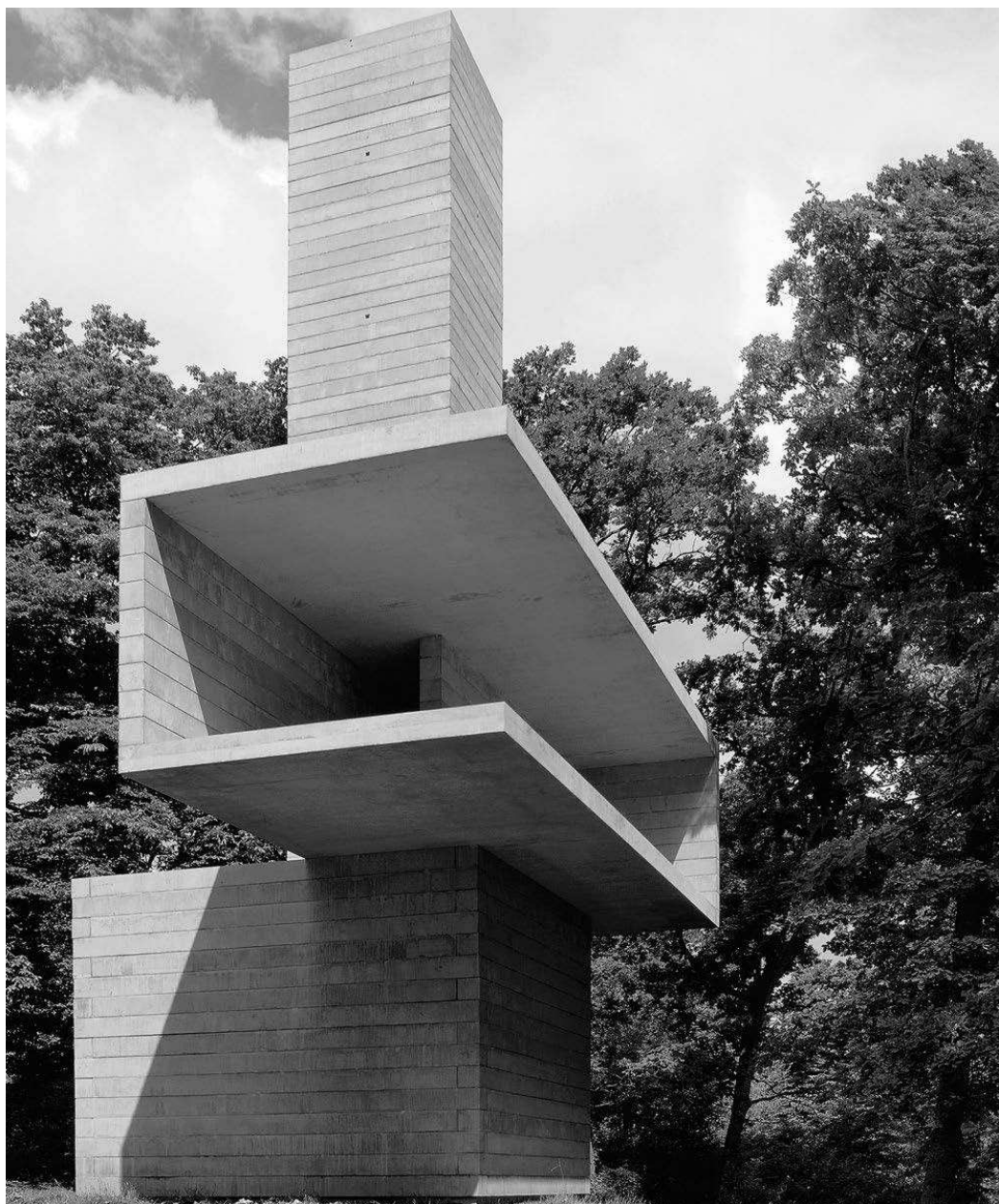
PAVILION KIVIK. Este edificio, de David Chipperfield y Antony Gormley, situado en la ciudad sueca de Österlen, está formado por tres volúmenes de 100 m 3 de hormigón. GERRY JOHANSSON
