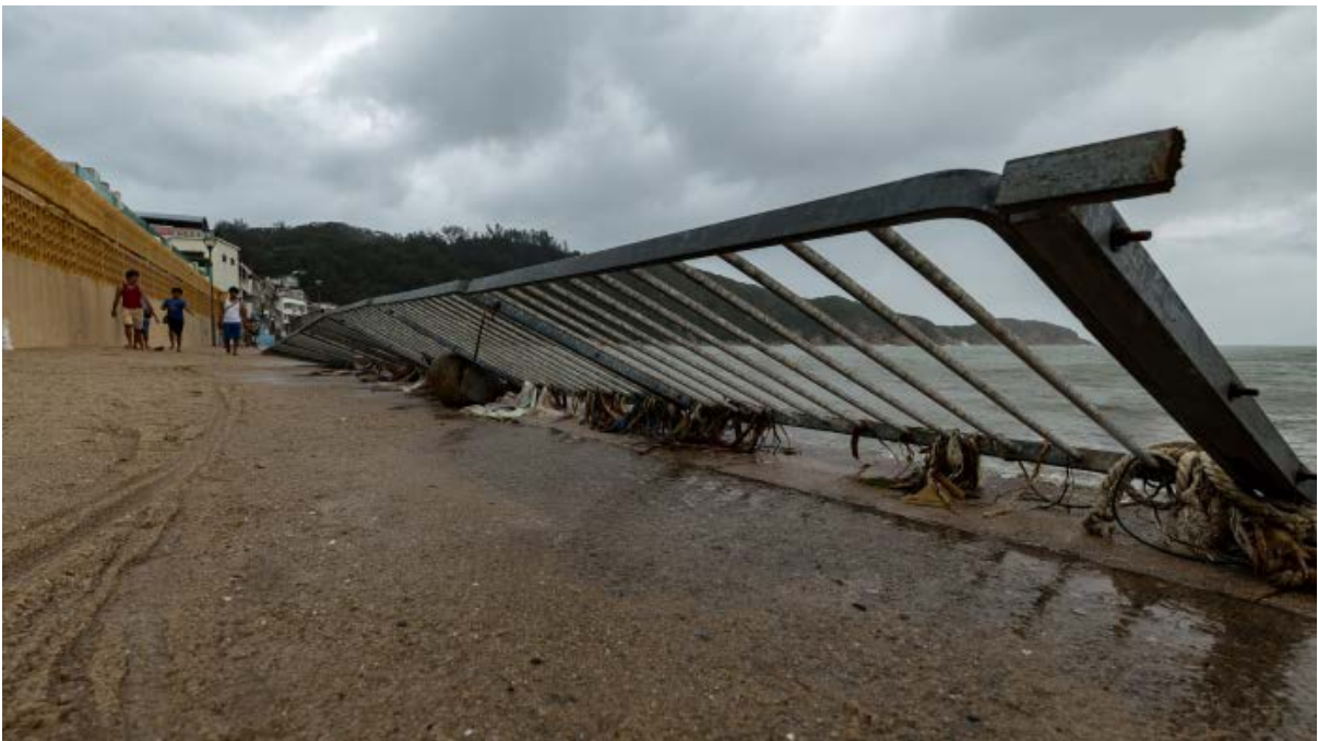
圖 3.3.19b 長洲東灣一帶的圍欄被海浪破壞。(圖片鳴謝: Remington Yu (社區天氣觀測計劃))
