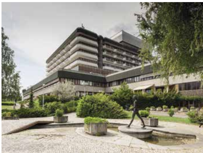
Obr. 34. Praha 5-Motol, čp. 37, Roentgenova 2, Nemocnice Na Homolce. Exteriér, pohled od JV, v popředí plastika Divka Petera Oriška (foto M. Kracík, 2017).
