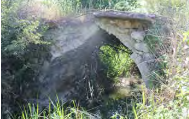
Resim 11: ALT 104 Şeyh İsa Köprüsü.
