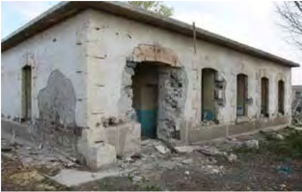
Resim 3: Bozkale Köyü okul binası.
