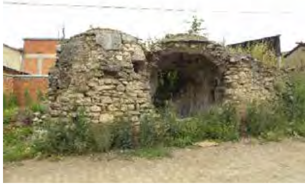
Resim 9: Ortaköy Mahallesi Hamamı, genel görünüşü.
