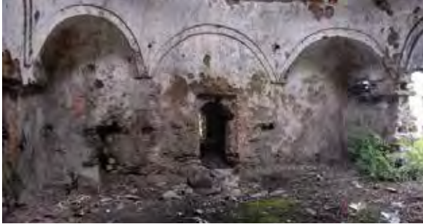
Resim 8: Yenice Mahallesi Hamamı, sıcaklığının genel görünüşü.
