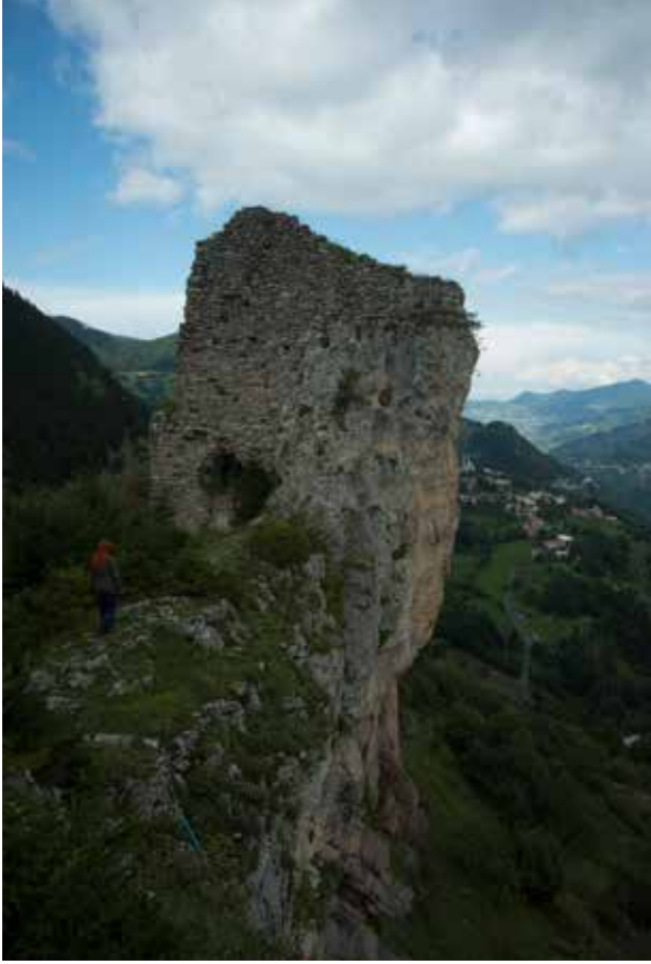
Resim 5: Düzköy, Çal Kale, Kireç harcıyla inşa edilen yapı kalıntısı.
