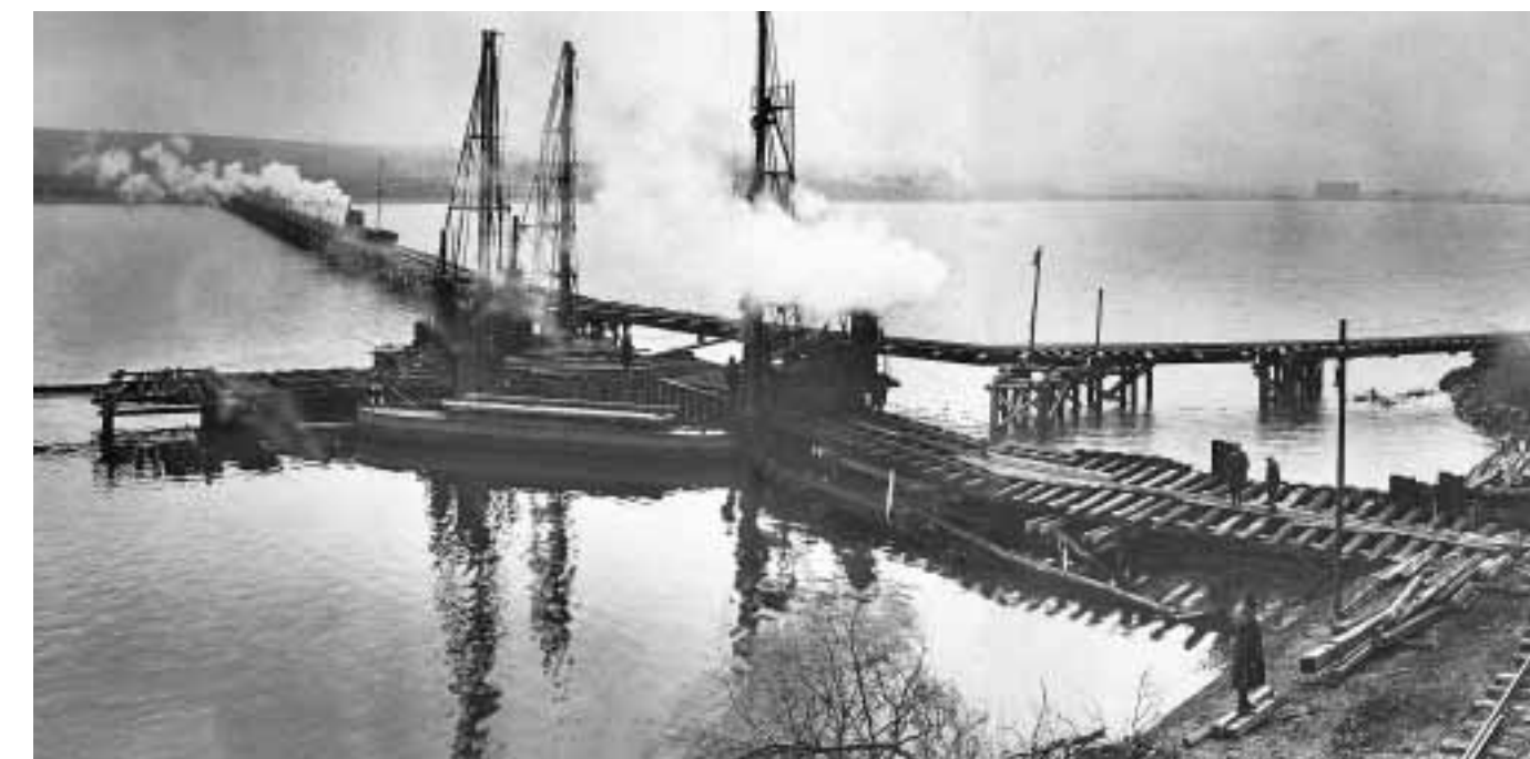
Blick auf den Fangedamm und die Transportbrücke 1928
