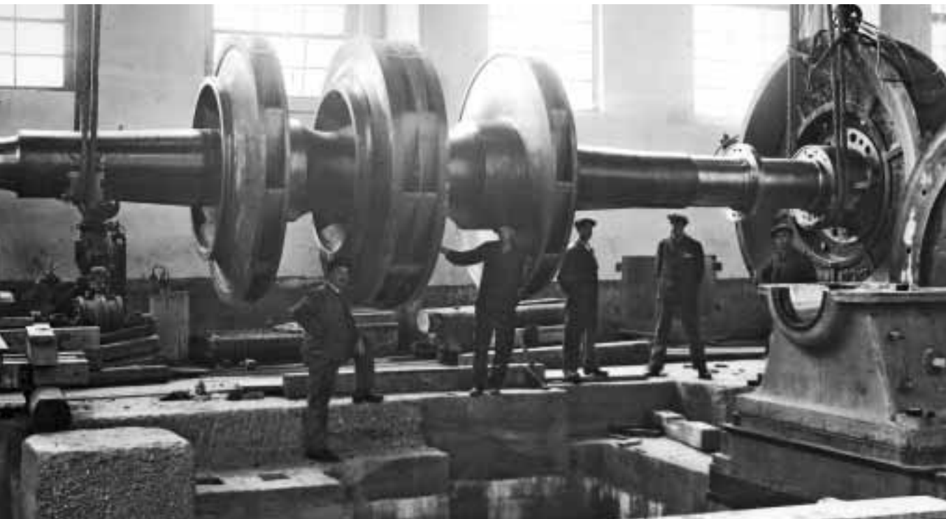
Montagearbeiten im Krafthaus 1929
