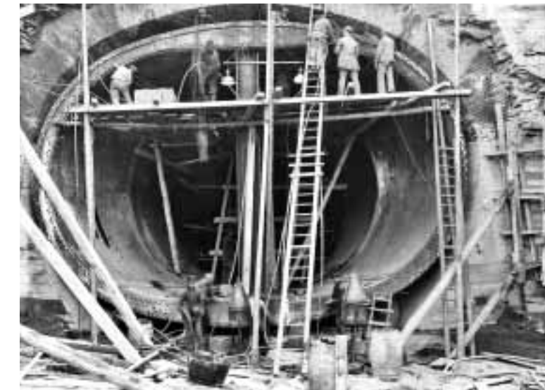
Die Einlauftrumpete während der Bauphase
