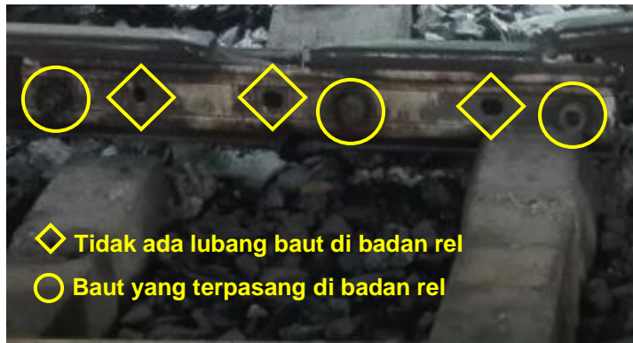
Gambar 13. Pemasangan pelat sambung pada rel yang patah
