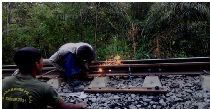
Gambar 12. Pembuatan lubang untuk sambungan baut menggunakan las pemotong pijar
