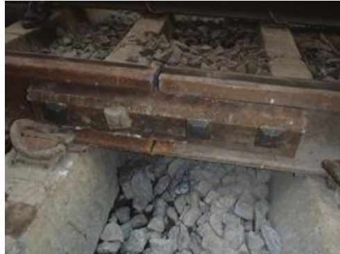
Gambar 11. Pelat sambung modifikasi dari rel yang dipotong
