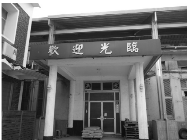
相 4-4.47 保護鋼棚施工現況-南向立面
