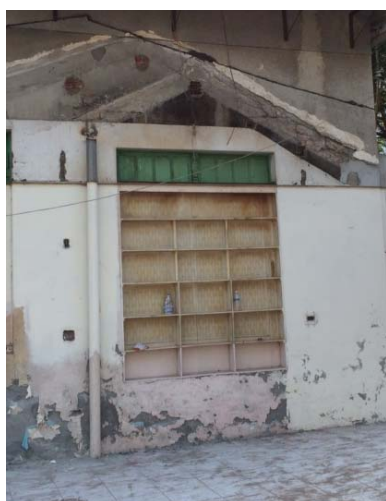
相 4-4.17 北面西邊門室外現況
