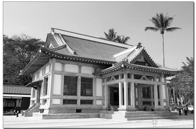
相 2-2.8 旗山武德殿
