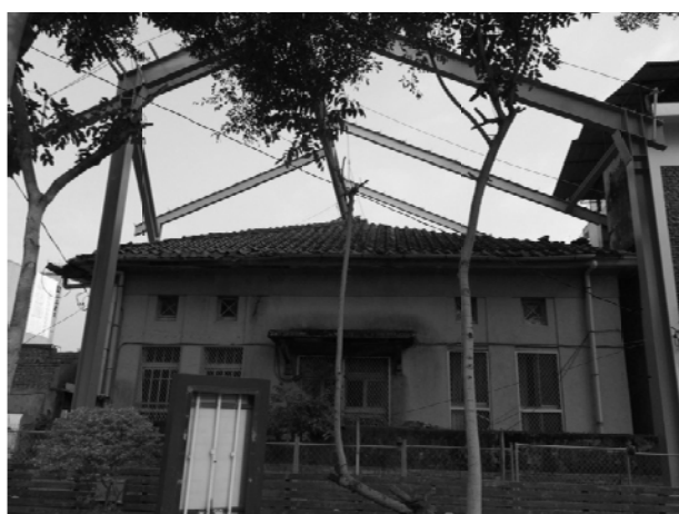
相 4-4.49 保護鋼棚施工現況-西向立面
