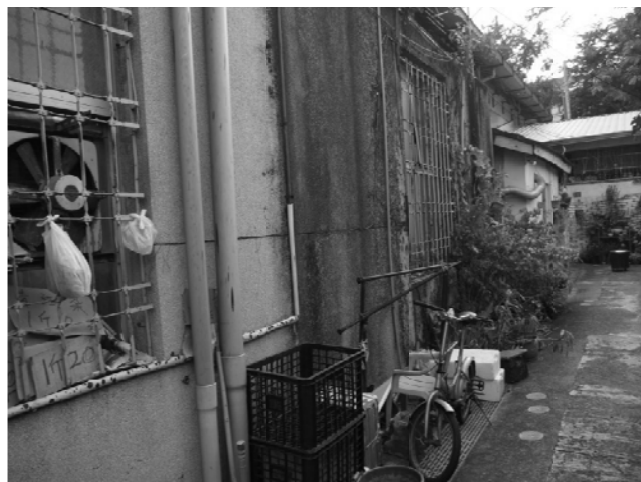
相 4-2.9 北側中華路 103 巷設排水溝
