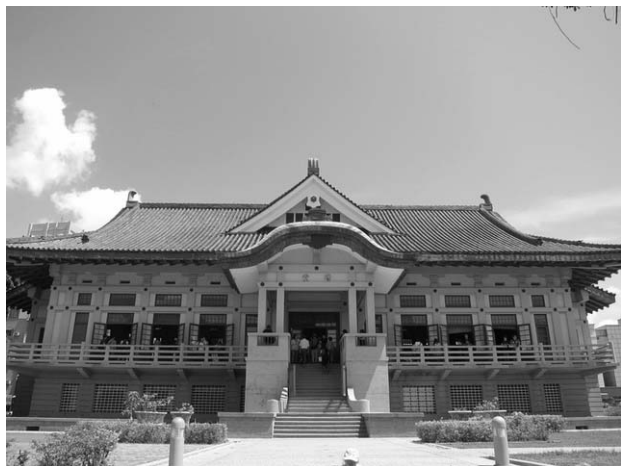
相 2-2.1 臺南武德殿
