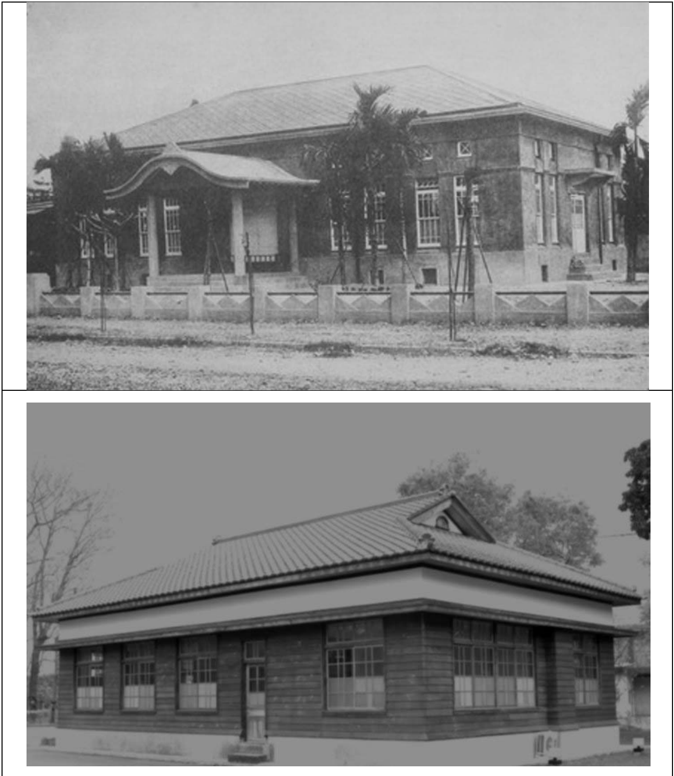
相 3-2.1 屏東演武場（上）與台南安溪國小禮堂（下）屋頂鋪設黑瓦紋路對照。
