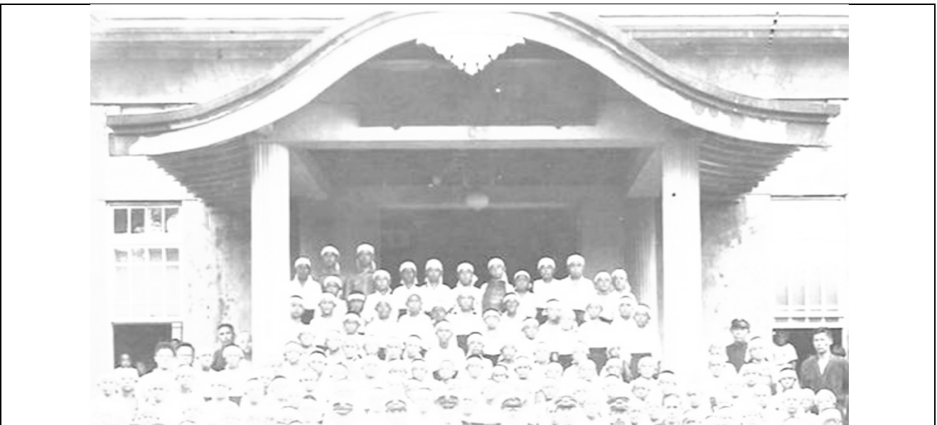
相 3-2.6 屏東演武場唐博風屋頂的柱上主樑為混凝土樑。平頂天花板。 資料來源：《台灣日式宿舍群 近來可好》臉書。照片提供人 Lin-Ting Chou
