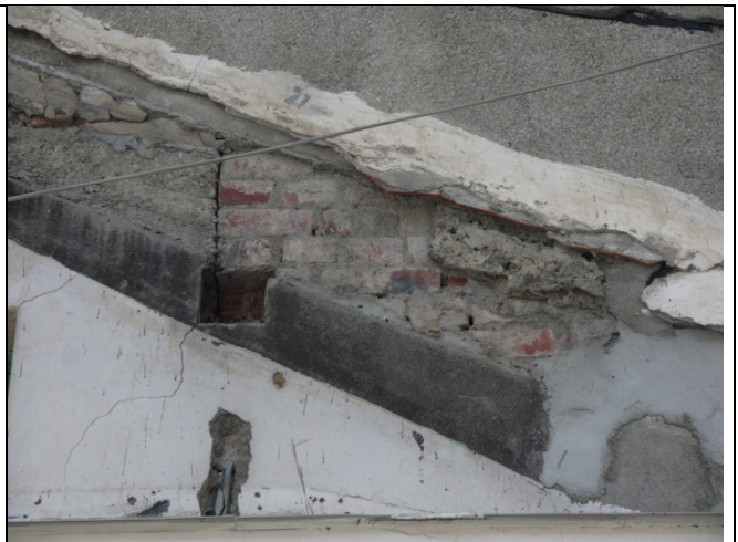
相 3-2.29 屏東演武場北立面牆露明磚牆砌法
