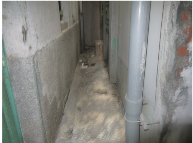
相 4-2.6 屏東演武場東側地坪-水泥鋪面
