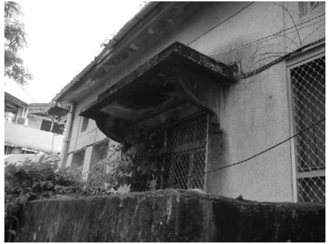
相 4-4.21 西側門水泥雨庇現況
