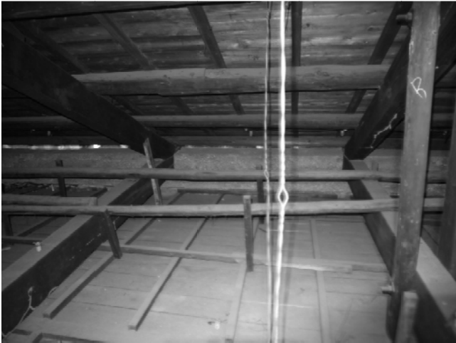
相 4-3.15 東、南、西三面磚牆頂設置混凝土屋簷板。室內。
