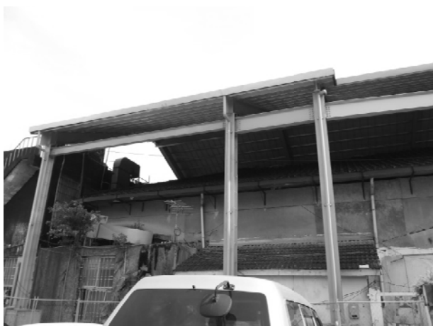
相 4-4.51 保護鋼棚施工現況-北向立面
