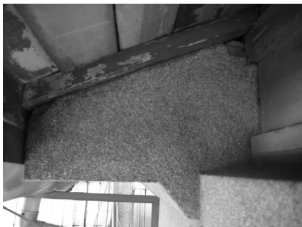
相 4-4.45 北面牆角隅混凝土板屋簷
