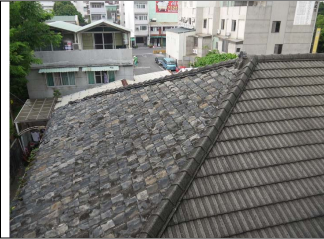
相 3-2.2 屏東演武場屋頂西面坡鋪設黑瓦
