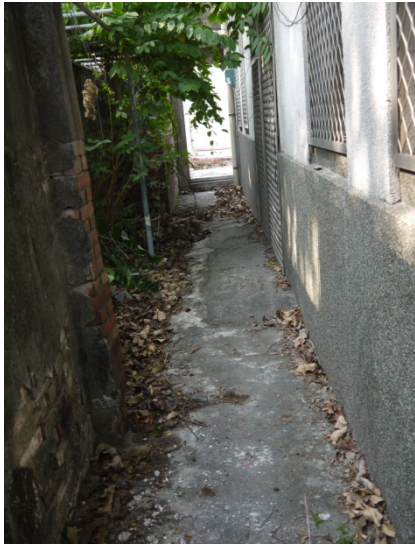
相 4-2.5 屏東演武場西側地坪-水泥鋪面
