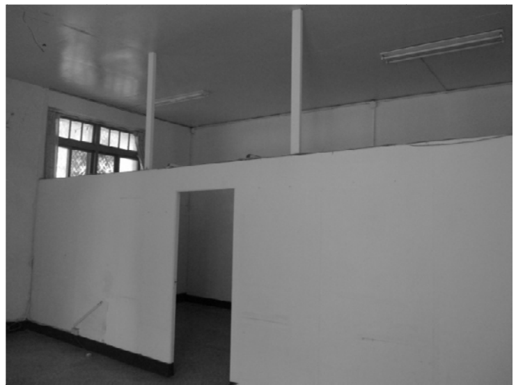
相 4-4.10 室內牆面現況
