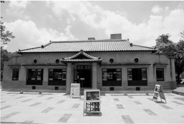
相 2-2.7 新化武德殿
