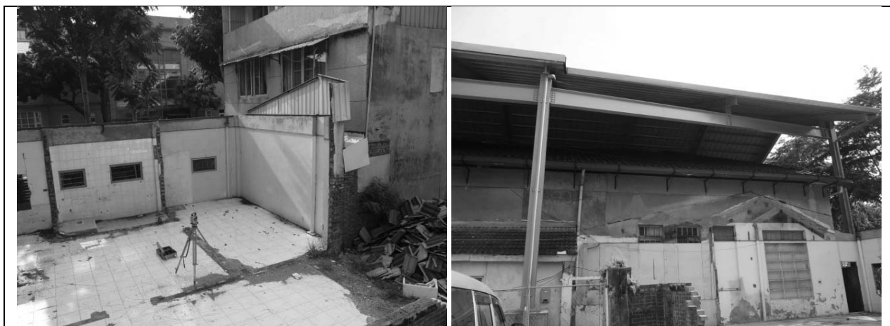
相 3-1.8 演武場西北側未辦保存建物拆除後現況 資料來源：105/05/18，屏東演武場周遭環境現況，本所人員拍攝
