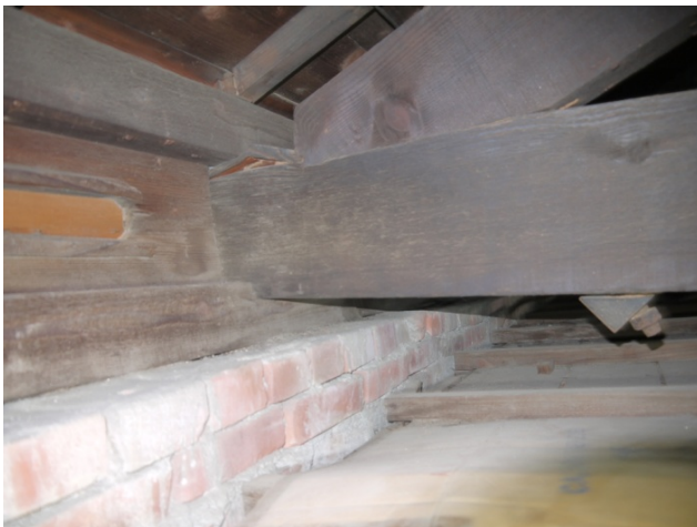
相 4-4.37 屋架陸梁敷桁榫接及螺栓接合
