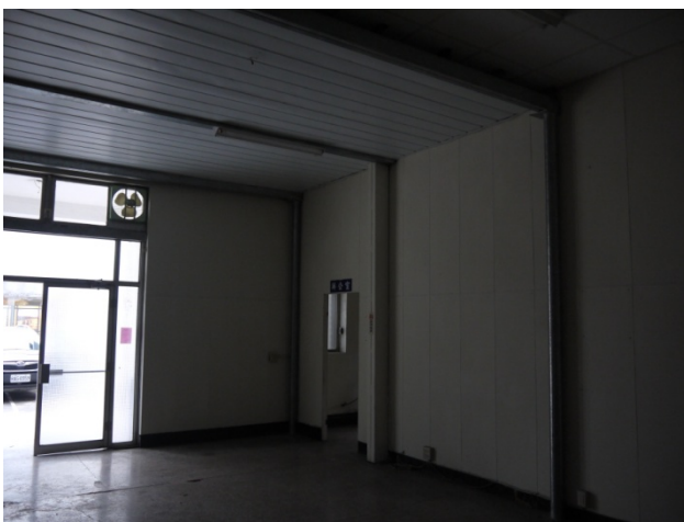
相 4-4.34 室內大廳鋼構補強天花板現況
