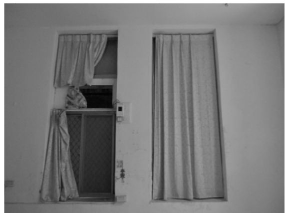
相 4-4.27 東面南邊更改為鋁窗現況
