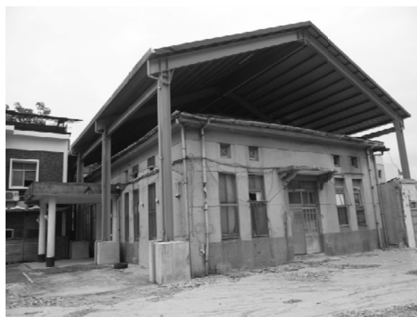
相 4-4.48 保護鋼棚施工現況-東向立面
