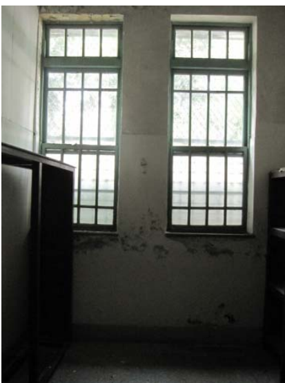
相 4-3.5 室內西北角隅空間
