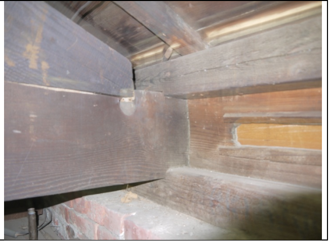
相 3-2.21 屋架陸梁置放固定於敷桁上
