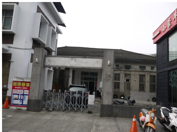
相 4-2.1 入口牌樓人行道-洗石子鋪面 南面圍牆大門入口牌樓
