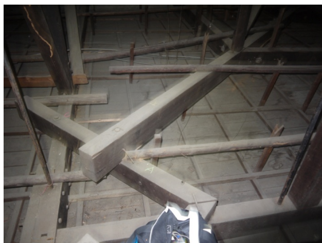
相 4-4.44 火打樑搭接及螺栓接合
