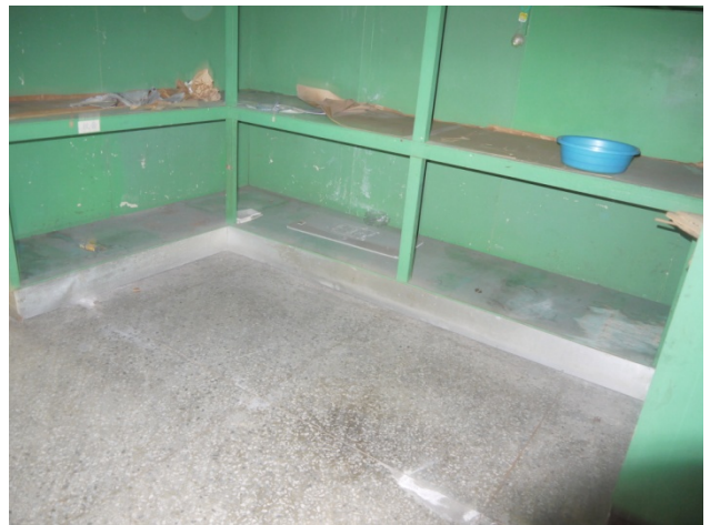
相 4-3.10 室內東北角隅空間
