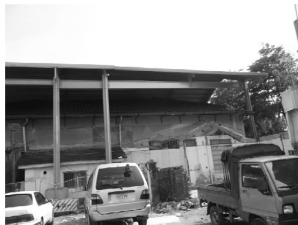
相 4-4.52 保護鋼棚施工現況-北向立面
