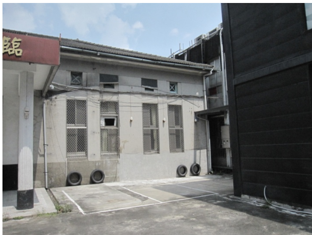
相 4-4.28 南面的氣窗與鋁上下疊窗現況
