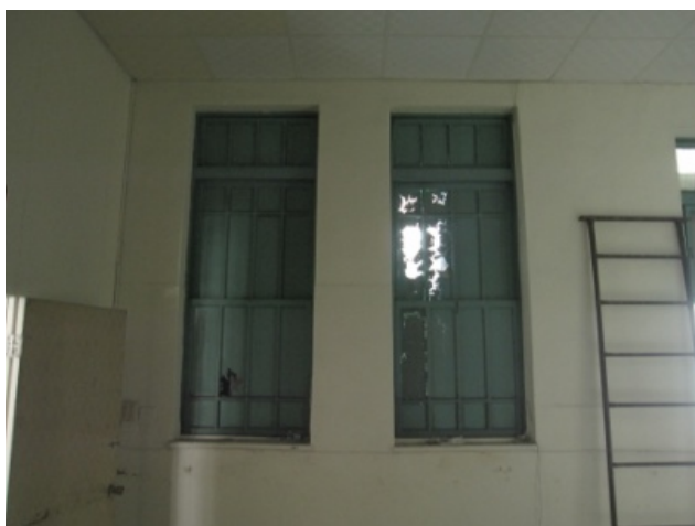
相 4-4.30 北面東邊的木作上下疊窗室內現況
