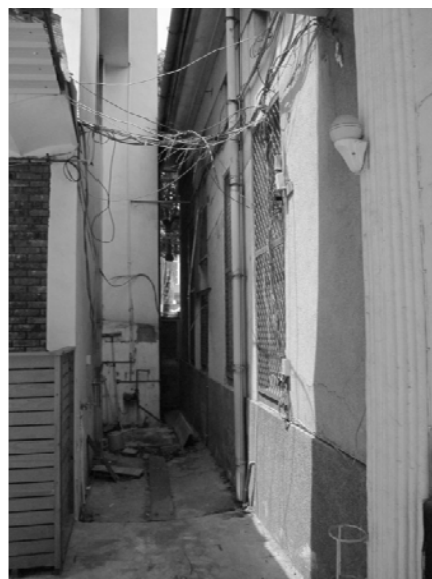
相 4-2.10 南側庭院主要以地表逕流排水
