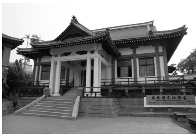
相 5-2.18 南投武德殿正立面
