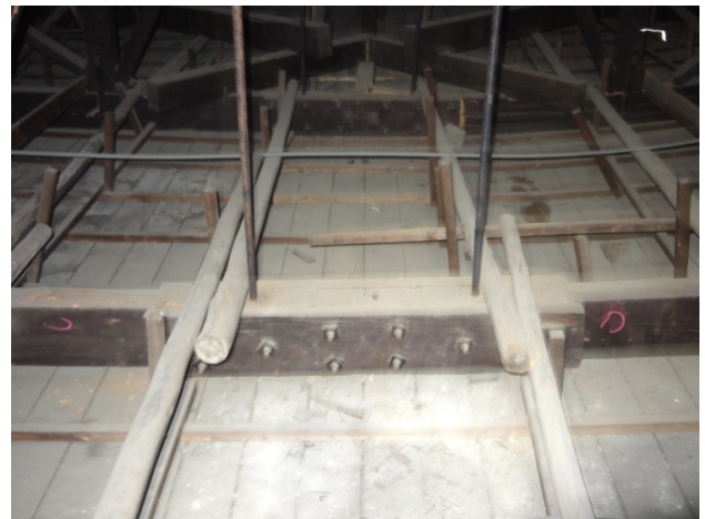
相 4-4.36 屋架陸梁鋼板、吊桿及螺栓接合
