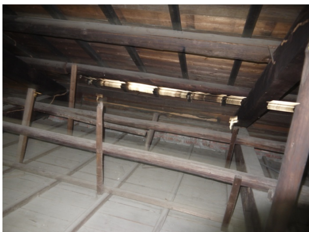
相 4-4.43 屋架天花板吊架鋼釘結合
