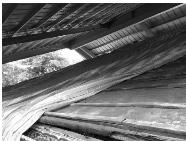
相 4-4.50 保護鋼棚施工現況-屋頂西南向
