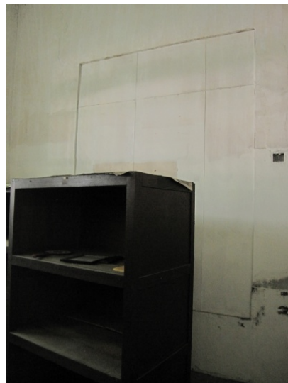
相 4-4.16 北面西後門封閉室內現況
