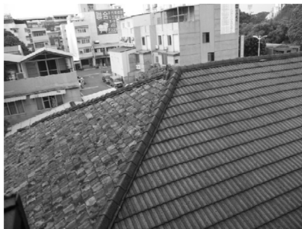
相 4-4.46 屋頂屋瓦拆除前狀況
