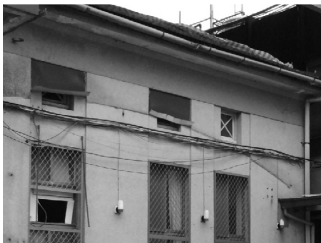
相 4-4.7 現況主體建築外牆及管線
