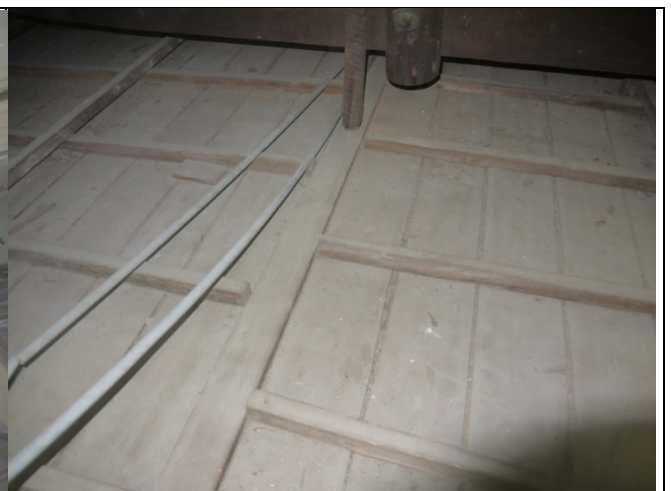
相 3-2.28 屏東演武場木造天井内部角材
