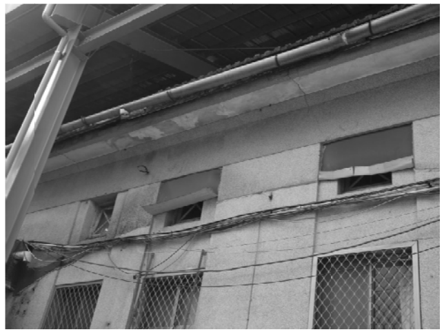
相 4-3.16 東、南、西三面磚牆頂設置混凝土屋簷板。室外。
