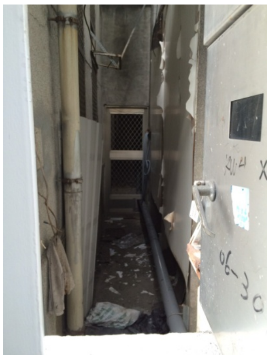
相 4-4.3 屏東演武場東側犬走現況
