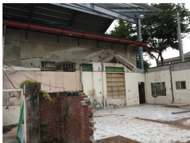
相 4-2.4 西北角宿舍建物拆除後-磁磚鋪面 西北側宿舍拆除後現況
