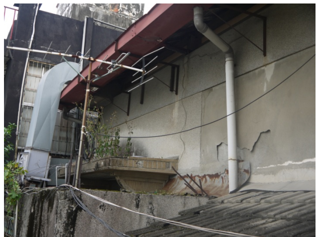
相 4-4.14 北面東後門水泥雨庇現況
