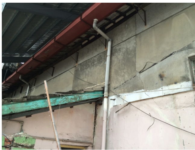
相 4-4.12 室外背牆神龕位置現況
