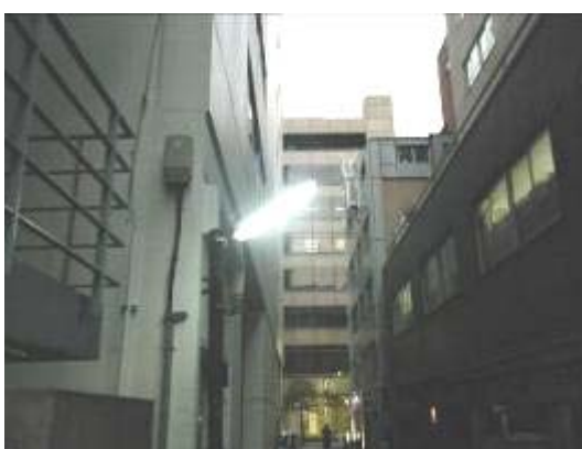
▲防犯灯の設置
