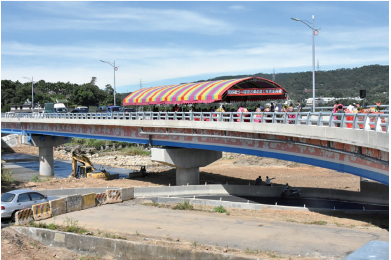
圖 8-2-9：關西鎮竹 116 線無名橋改建工程通車典禮（關西鎮公所提供）
