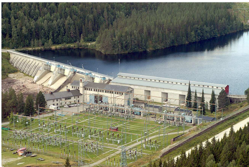
Figur 2. Flygfoto över Krångede kraftverk.
