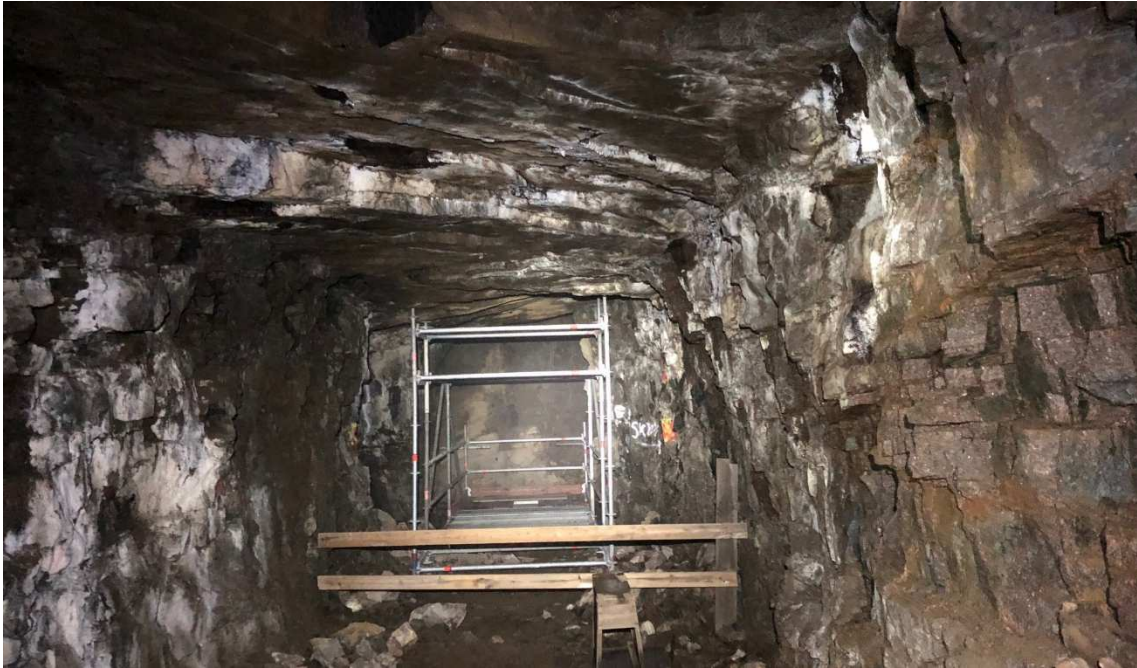
Figur 8. Foto från befintlig arbetstunnel där för området typiska strukturer resulterar i en rektangulär tunnelsektion.
