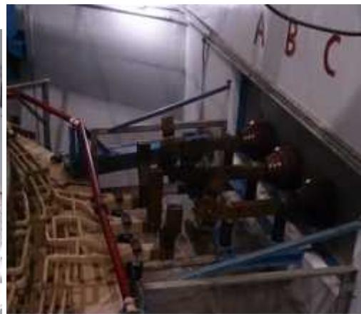
Fig. 4.1.1.1 Lado neutro desconectado.
