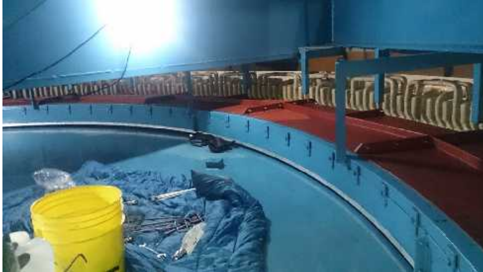
Fig. 4.2.12 Colocación de tolvas
