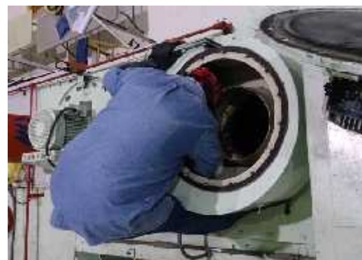
Fig. 4.3.1.2.1 Limpieza a extractores
