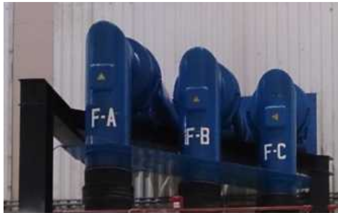
Fig. 4.3.5 Limpieza a la envolvente del bus
