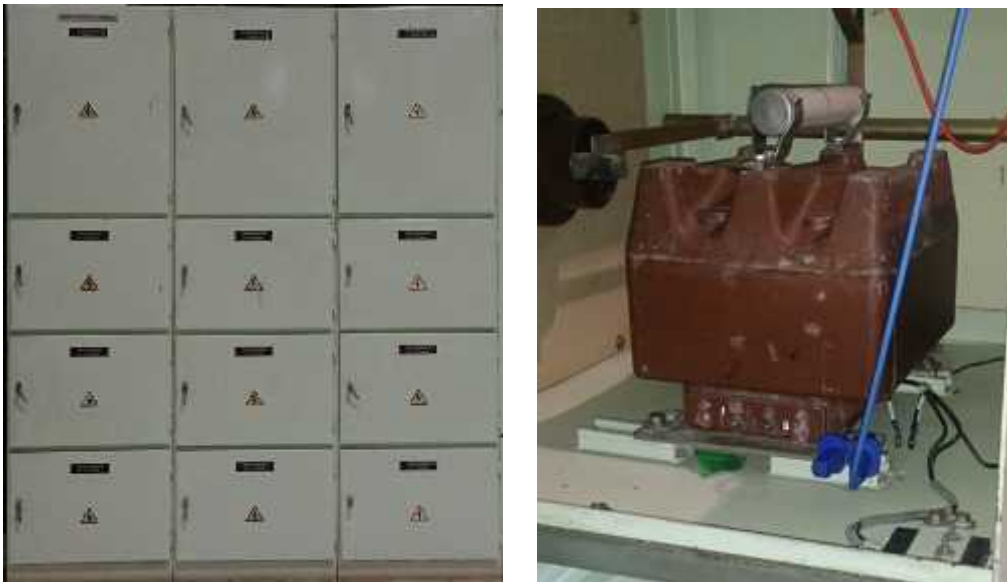
Fig. 2.4 Tablero metal clad.
