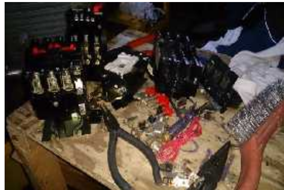
Fig. 4.3.11.1 Mantenimiento a contactores
