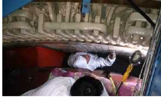
Fig. 4.1.5.2 Revisión del acuñado parte inferior Fig. 4.1.5.3 Revisión de acuñado superior
