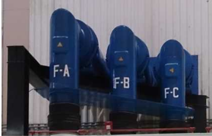
Fig. 1.4.4 Bus de fase aislada.
