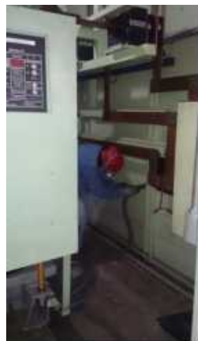
Fig. 4.3.3 Limpieza a transformador de servicios propios.
