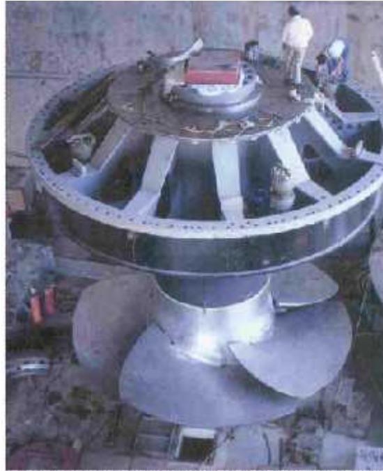
Fig. 1.4.3 Turbina Kaplan.
