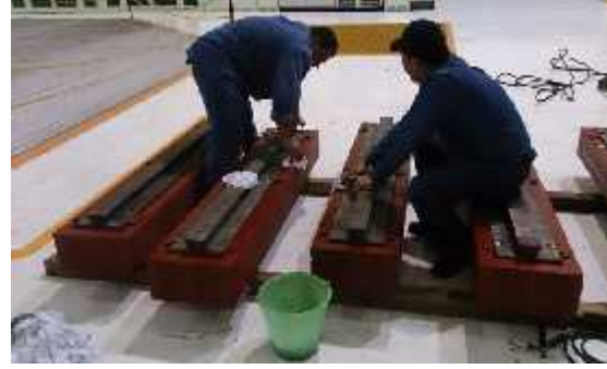
Fig. 4.2.8.1 Limpieza de polos con dielectrol
