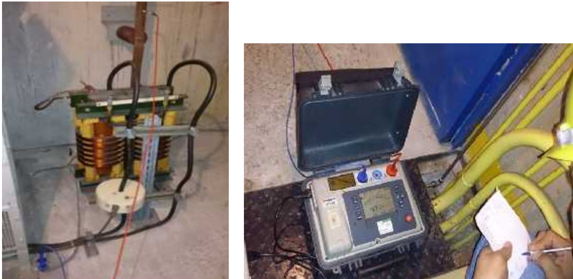
Fig. 4.1.4 Prueba de resistencia de aislamiento al conjunto
