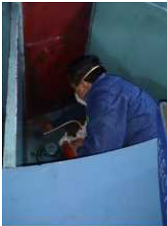
Fig. 4.2.10 Limpieza al piso y a los huecos de la araña del rotor
