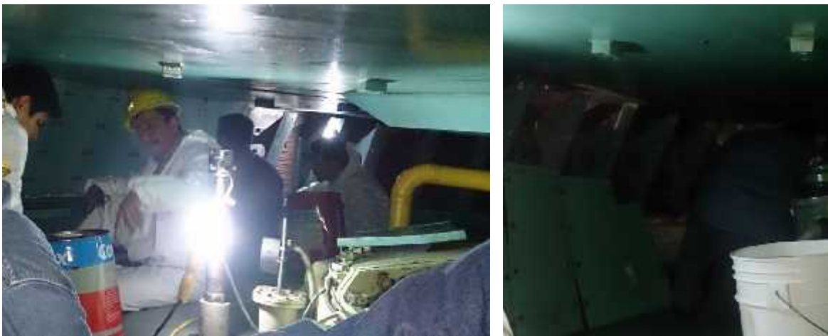
Fig. 4.1.3 Retiro de las tapas inferiores del estator
