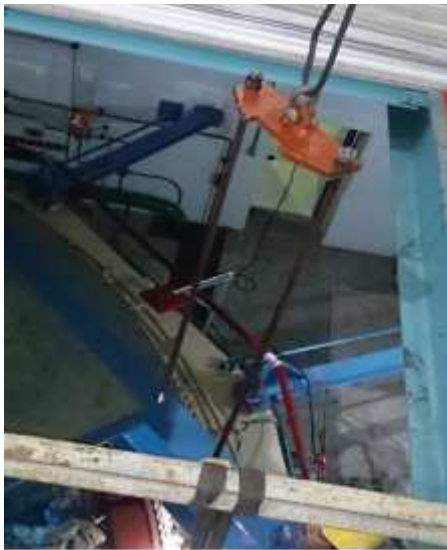
Fig. 4.2.7 Colocación de dispositivo para el izaje
