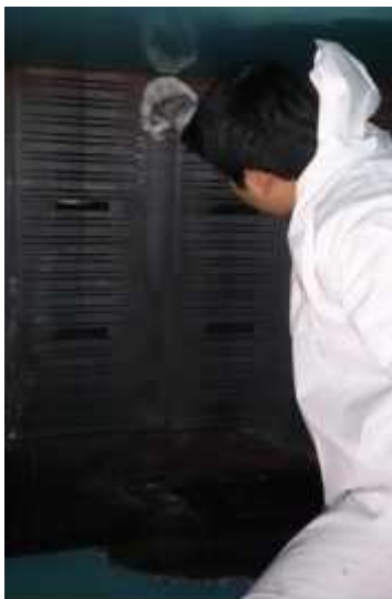
Fig. 4.2.10.1 Limpieza de ductos de ventilación del rotor
