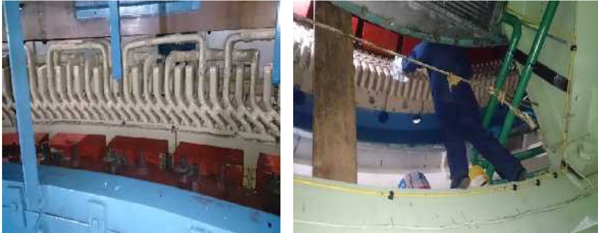
Fig. 4.1.7 Limpieza detallada de cabezales
