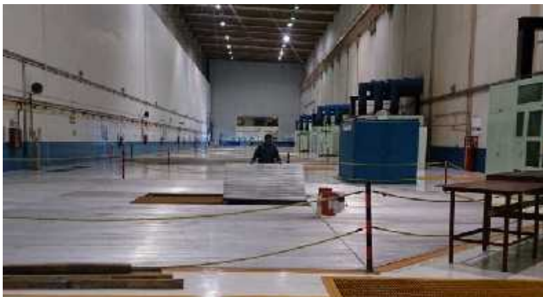
Fig. 4.1.10 Colocación de tapa antiderrapante
