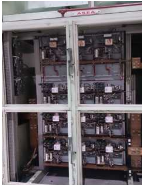
Fig. 1.4.10 Rectificador de tiristores
