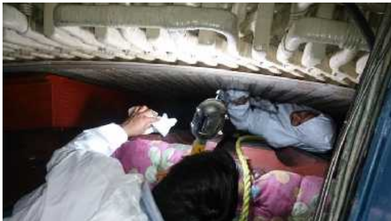
Fig. 4.1.5 Limpieza al laminado del estator
