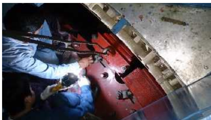
Fig. 4.2.11. 6 Colocación de perno
