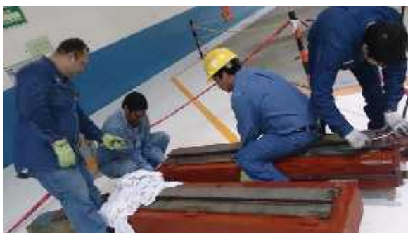
Fig. 4.2.11 Colocación de dispositivo para el izaje
