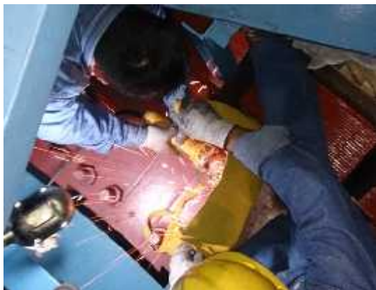
Fig. 4.2.5 Esmerilado de punto de soldadura
