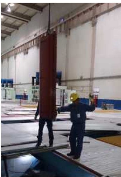
Fig. 4.2.11. 2 Direccionando el polo.
