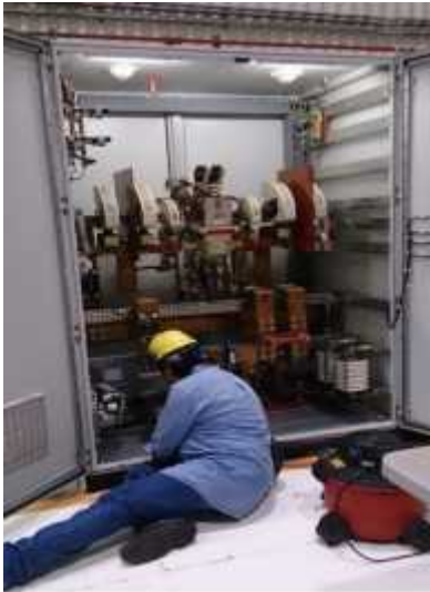
Fig. 4.3.1.1 Limpiezas a quebradora
