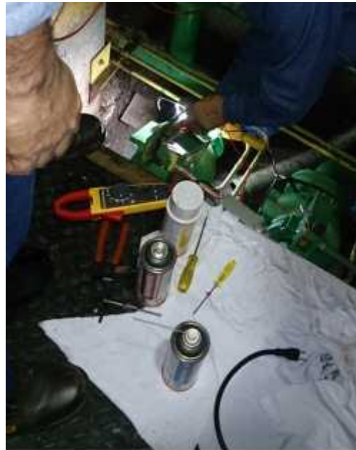
Fig. 5.3.9 Mantenimiento a micros de agua de enfriamiento
