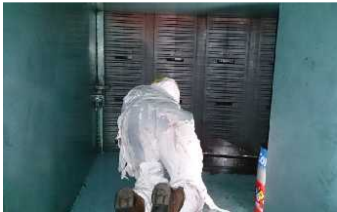
Fig. 4.2.10 Limpieza al piso y a los huecos de la araña del rotor
