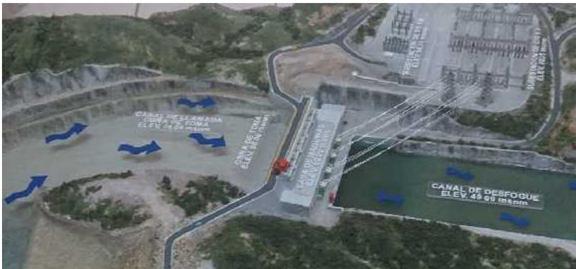
Fig. 1.3.5 Obra de toma y canal de desfogue.
