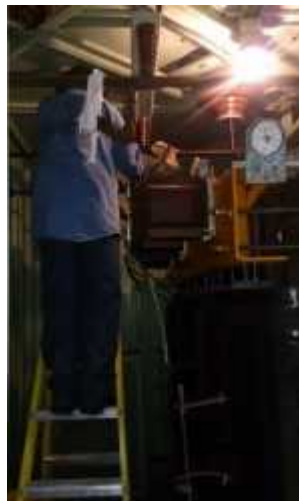
Fig. 4.3.3 Limpieza a transformador de servicios propios.
