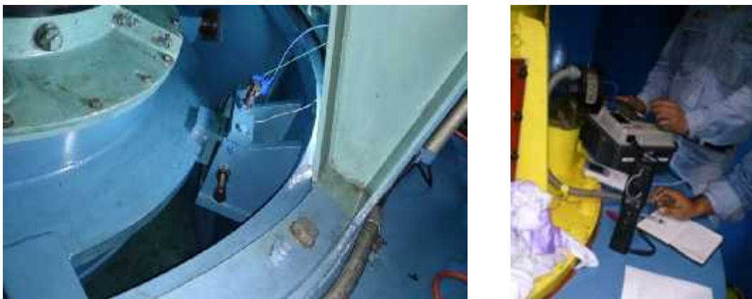
Fig. 4.3.6 Prueba de resistencia de aislamiento
