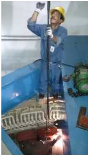
Fig. 4.2.7.2 Inicio de izaje
