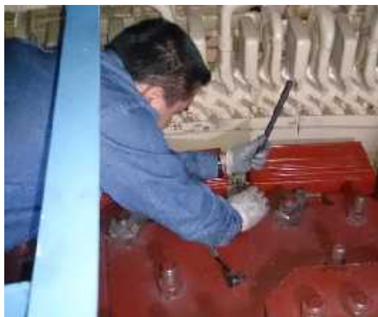
Fig. 4.2.6 Retiro de las conexiones entre polos
