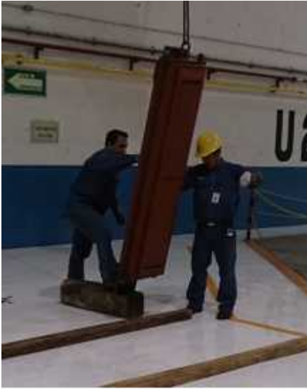
Fig. 4.2.7.4 Colocación de dispositivo
