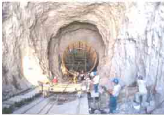
Figura II.3.3.2-39 Foto de un proyecto que ejemplifica la Colocación de cimbra para el colado del codo de la tubería a presión.
