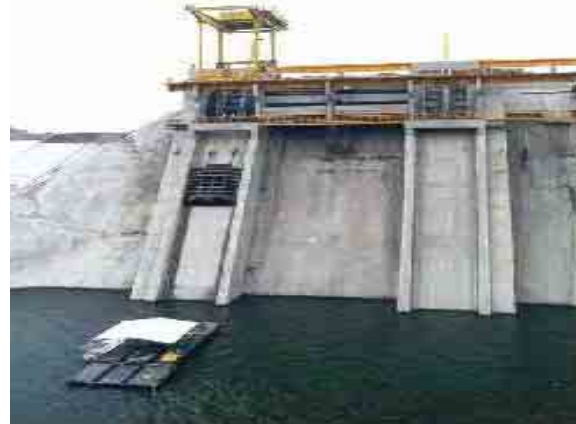
Figura II.3.3.2-75 Foto de un proyecto que ejemplifica el Izaje de compuerta auxiliar con apoyo de grúa pórtico
