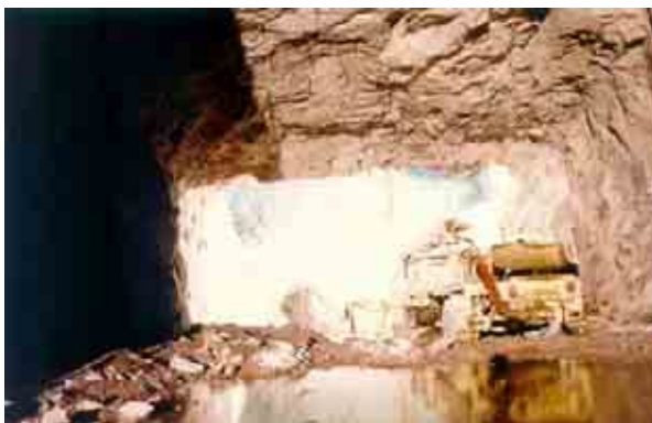
Figura II.3.3.2-48 Foto de un proyecto que ejemplifica la Excavación de túneles de aspiración
