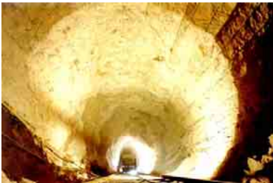
Figura II.3.3.2-36 Foto de un proyecto que ejemplifica la Excavación a sección completa en tuberías a presión
