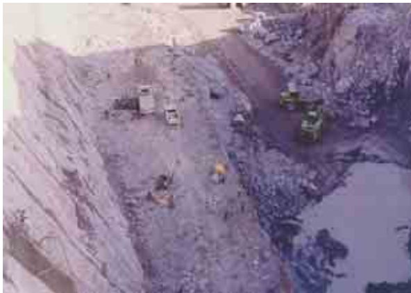
Figura II.3.3.2-22 Foto de un proyecto que ejemplifica la Excavación de la obra de toma
