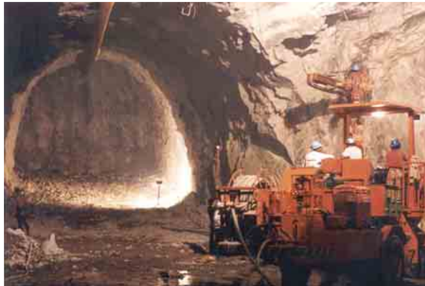
Figura II.3.3.2-52 Foto de un proyecto que ejemplifica la Barrenación para anclaje en las paredes de la caverna. Al fondo se nota el túnel auxiliar al tímpano norte de la casa de máquinas.
