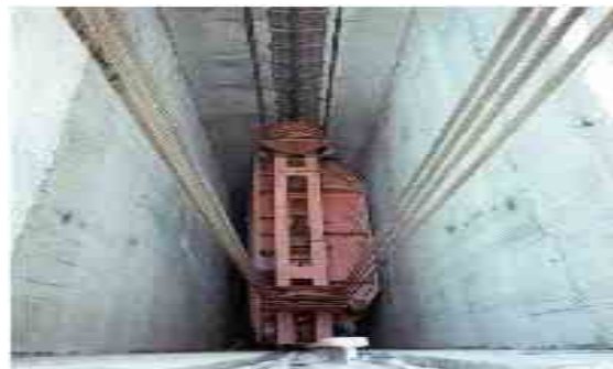
Figura II.3.3.2-71 Foto de un proyecto que ejemplifica el Deslizamiento de la compuerta de cierre final.
