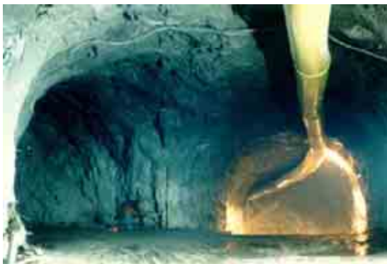
Figura II.3.3.2-46 Foto de un proyecto que ejemplifica la Excavación de túnel auxiliar a tuberías a presión y tímpano norte de casa de máquinas
