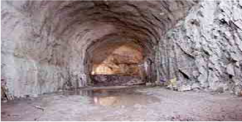
Figura II.3.3.2-57 Foto de un proyecto que ejemplifica la Excavación de la galería para izaje de compuertas
