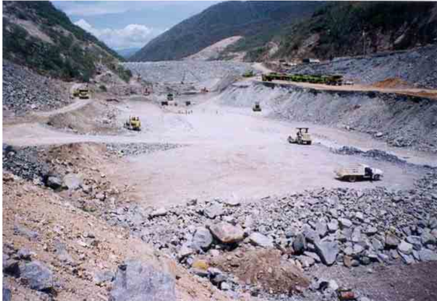
Figura II.3.3.2-17 Foto de un proyecto que ejemplifica el Proceso de construcción del carcamo de bombeo y limpieza del recinto de la cortina con retroexcavadoras
