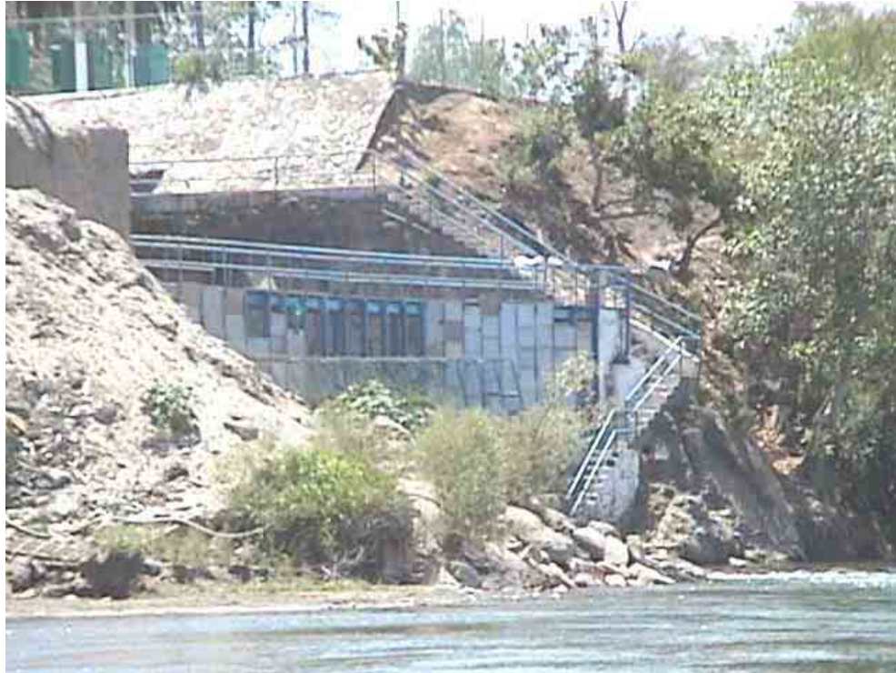
Fotografía H2. Embalse utilizado para la extracción de agua del río Papagayo, para el abastecimiento de agua potable al puerto de Acapulco.
