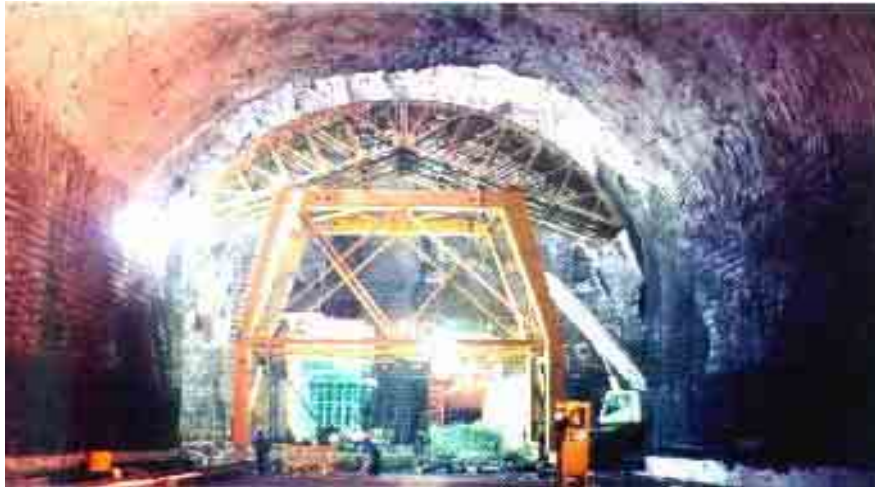
Figura II.3.3.2-63 Foto de un proyecto que ejemplifica el Montaje de piezas centrales para colado de la clave del túnel. Proceso de colado de muros y bóveda
