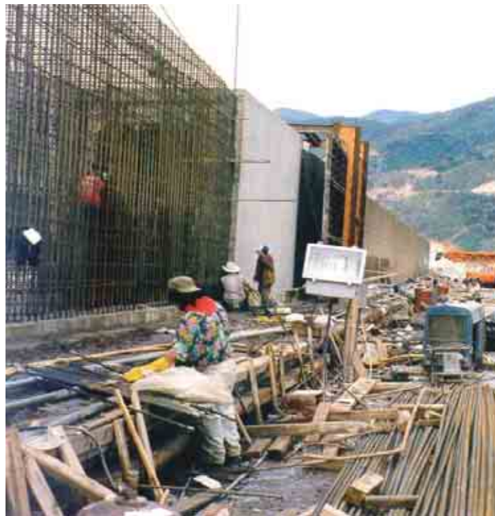
Figura II.3.3.2-70 Foto de un proyecto que ejemplifica la Construcción del muro divisorio del canal de descarga de la Obra de Excedencias con utilización de cimbra metálica Obras de Contención.
