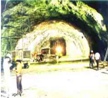
Figura II.3.3.2-44 Foto de un proyecto que ejemplifica la Excavación de la bóveda de la caverna de casa de máquinas
