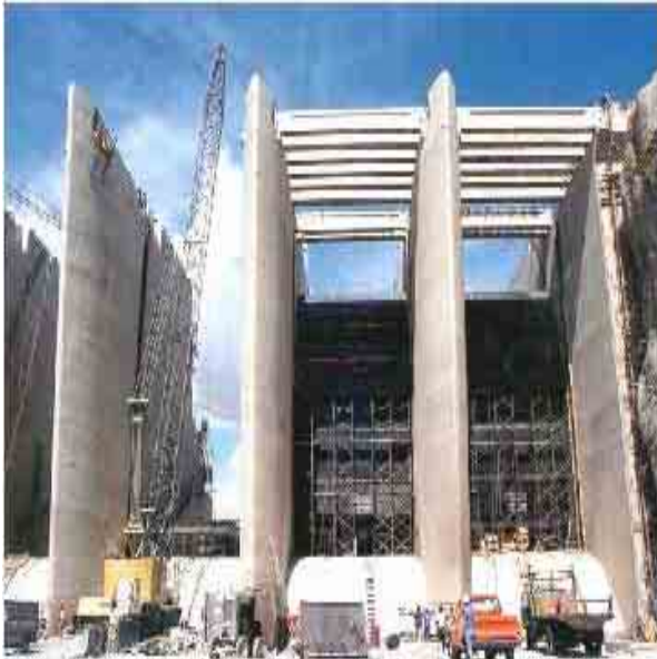
Figura II.3.3.2-72 Foto de un proyecto que ejemplifica el Montaje de las compuertas radiales
