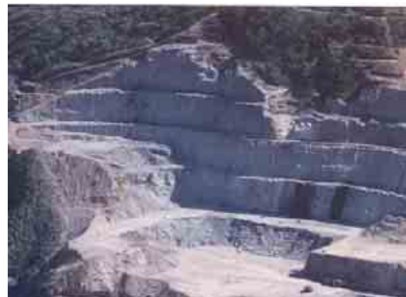
Figura II.3.3.2-23 Foto de un proyecto que ejemplifica la Excavación del canal de llamada de la obra de toma
