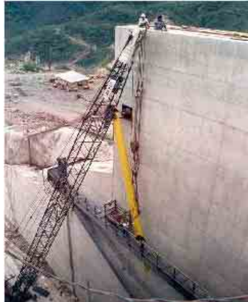
Figura II.3.3.2-73 Foto de un proyecto que ejemplifica el Proceso de montaje de los servomotores
