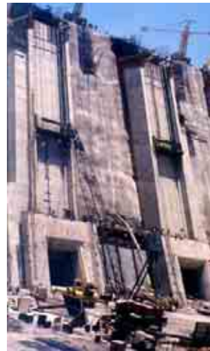
Figura II.3.32-28 Foto de un proyecto que ejemplifica el Revestimiento con concreto armado en bocatomas y torres de compuertas.
