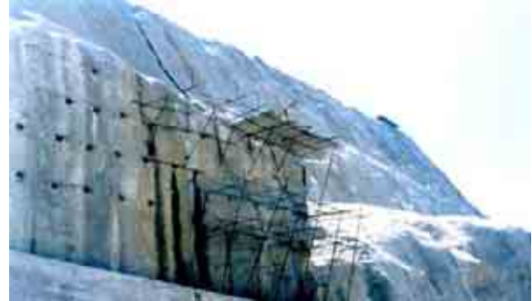
Figura II.3.3.2-25 Foto de un proyecto que ejemplifica el Revestimiento de mortero lanzado y soporte por medio de anclaje
