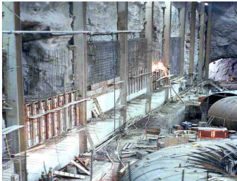
Figura II.3.3.2-54 Anclaje en la caverna de casa de máquinas
