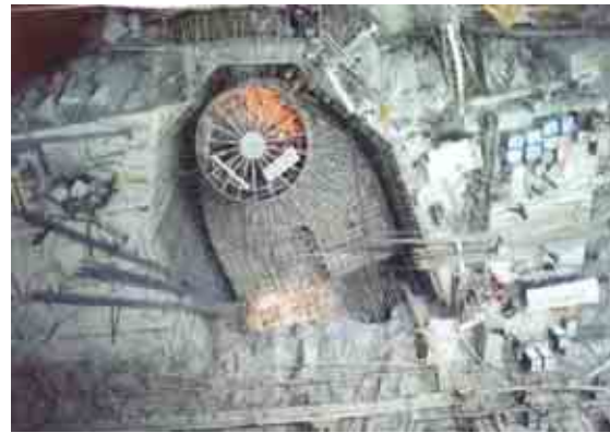
Figura II.3.3.2-79 Foto de un proyecto que ejemplifica la Vista superior del tubo de aspiración
