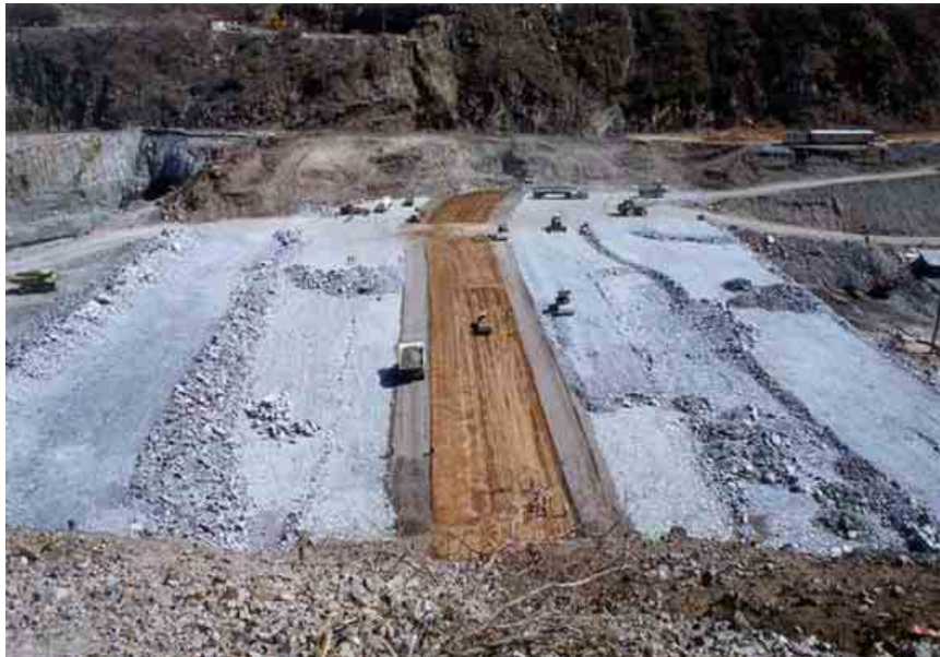
Figura II.3.3.2-18 Foto de un proyecto que ejemplifica la Formación de terraplenes en la cortina.
