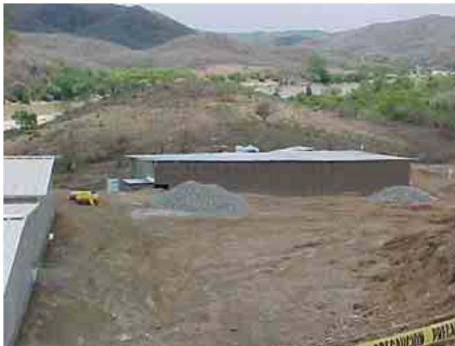
Figura II.3.3.2-6 Almacén de materiales
