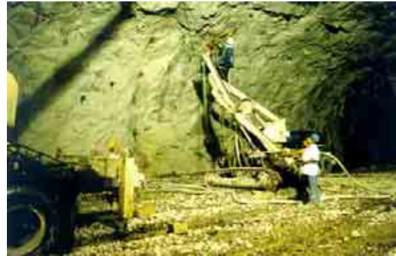
Figura II.3.3.2-51 Foto de un proyecto que ejemplifica la Colocación de anclas con track-drill en la bóveda de la caverna de casa de máquinas
