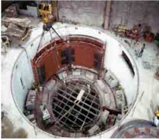
Figura II.3.3.2-84 Foto de un proyecto que ejemplifica la Colocación del segundo sector del estator dentro del foso
