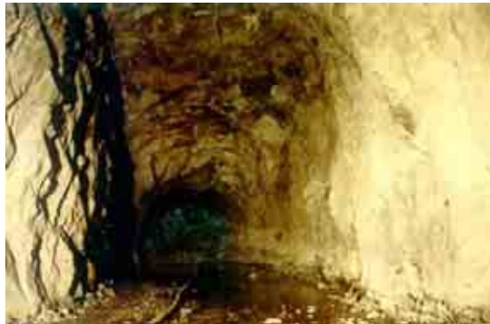
Figura II.3.3.2-47 Foto de un proyecto que ejemplifica la Excavación túnel piloto de aspiración. Al fondo se observa el foso de una de las unidades en casa de máquinas
