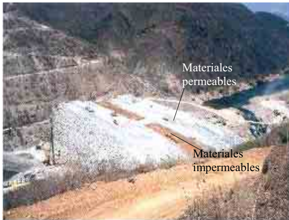
Figura II.3.3.2-11 Foto de un proyecto que ejemplifica la Ataguía de aguas arriba en proceso de construcción, formada con materiales graduados y corazón impermeable de arcilla
