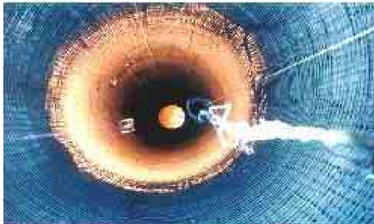
Figura II.3.3.2-65 Foto de un proyecto que ejemplifica la Colocación de acero de refuerzo para el revestimiento con concreto en lumbreras
