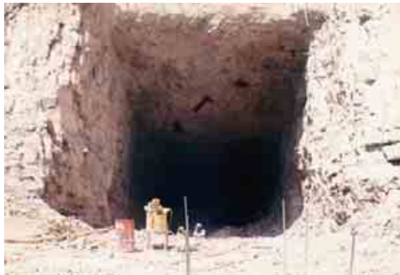
Figura II.3.3.2-32 Foto de un proyecto que ejemplifica la Excavación del tramo bocatoma – transición – codo superior
