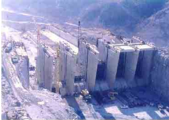
Figura II.3.3.2-68 Foto de un proyecto que ejemplifica el Proceso de revestimiento con concreto en estructura de control.
