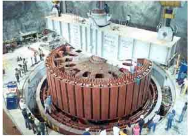
Figura II.3.3.2-85 Foto de un proyecto que ejemplifica la Colocación del rotor dentro del foso
