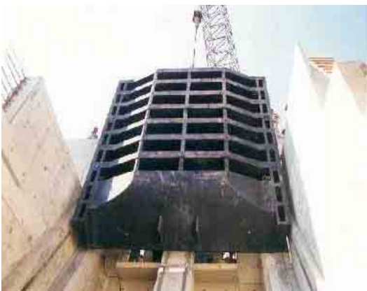
Figura II.3.3.2-74 Foto de un proyecto que ejemplifica el Proceso montaje de compuerta de servicio sobre viguetas móviles
