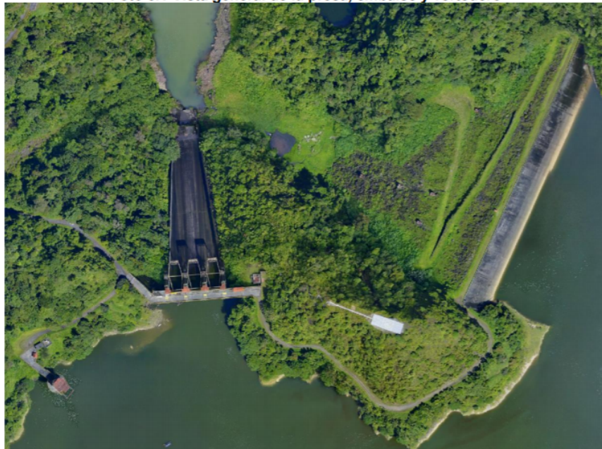
Foto 3.1 Vista general de la presa, embalse y vertedero
