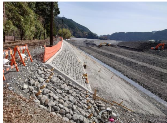
下泉駅～田野口駅間大井川護岸工事
