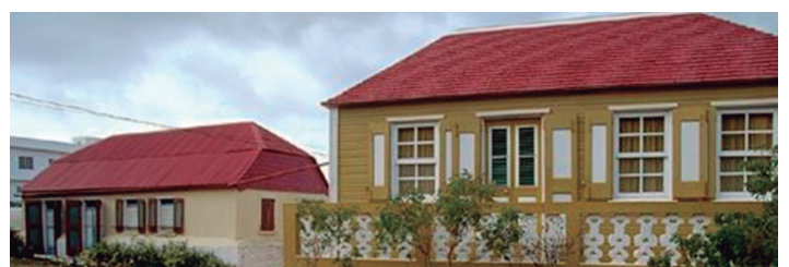
▲ Casas a prueba de huracanes. De julio a octubre de cada año la isla es azotada por violentos huracanes. Después que los vientos de más de 225 km/h del huracán Donna asolaran la desprevenida isla en 1960, construyeron sólidas casas capaces de resistir estos vientos huracanados. Hoy en día la mayor parte de las casas están construidas con hormigón armado, incluidas las tradicionales.
