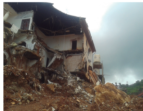
▲ Freetown, septiembre de 2017. En esta imagen se aprecian los daños causados por los deslizamientos de tierra durante las intensas lluvias de agosto. Al extremo derecho se observa la ruta de dicho fenómeno.
