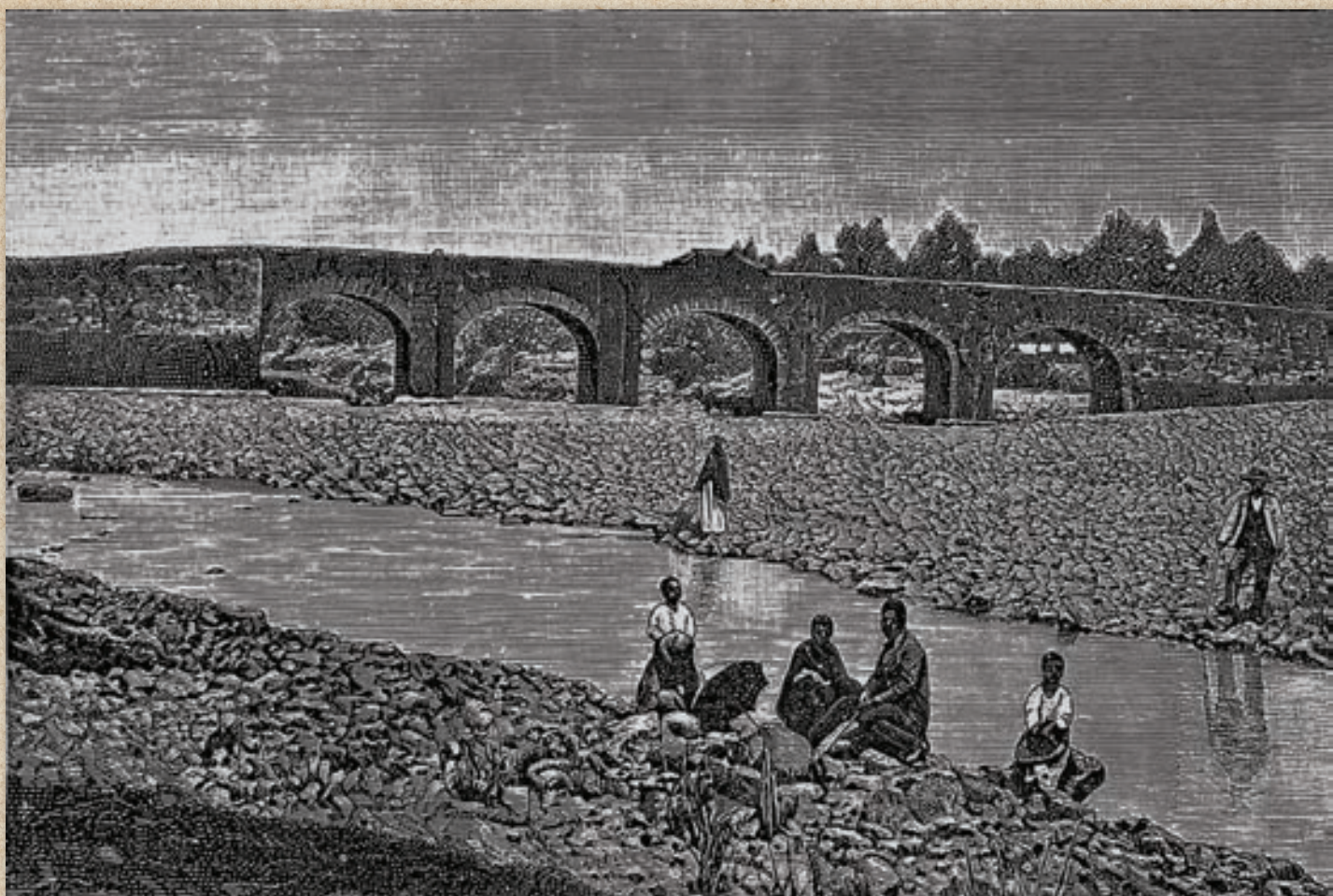
Puente Nacional de San Juan del Río, en el camino carretero que conduce a Querétaro. México a través de los siglos , 1888.
